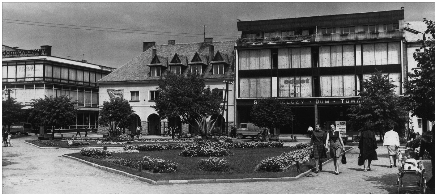
Pierwsza koncepcja przebudowy Rynku pojawiła się w 1963 roku. Projekt architektoniczny opracował zespół pod kierunkiem inż. arch. Jana Buzka. Do budowy przystąpiono w grudniu 1970 roku
