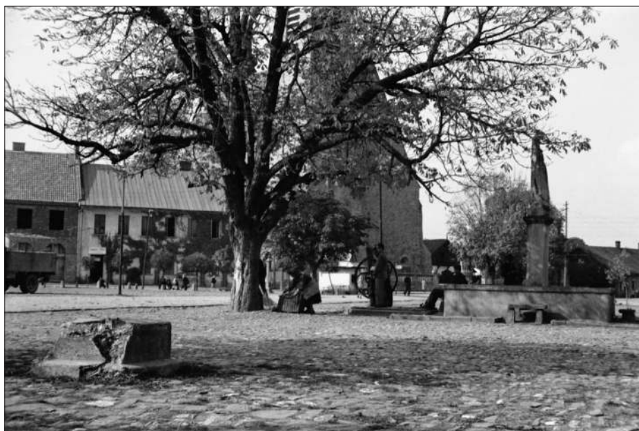
Fragment budynków, jeszcze w stanie surowym, po zachodniej stronie rynku. Koniec lat czterdziestych XX wieku
