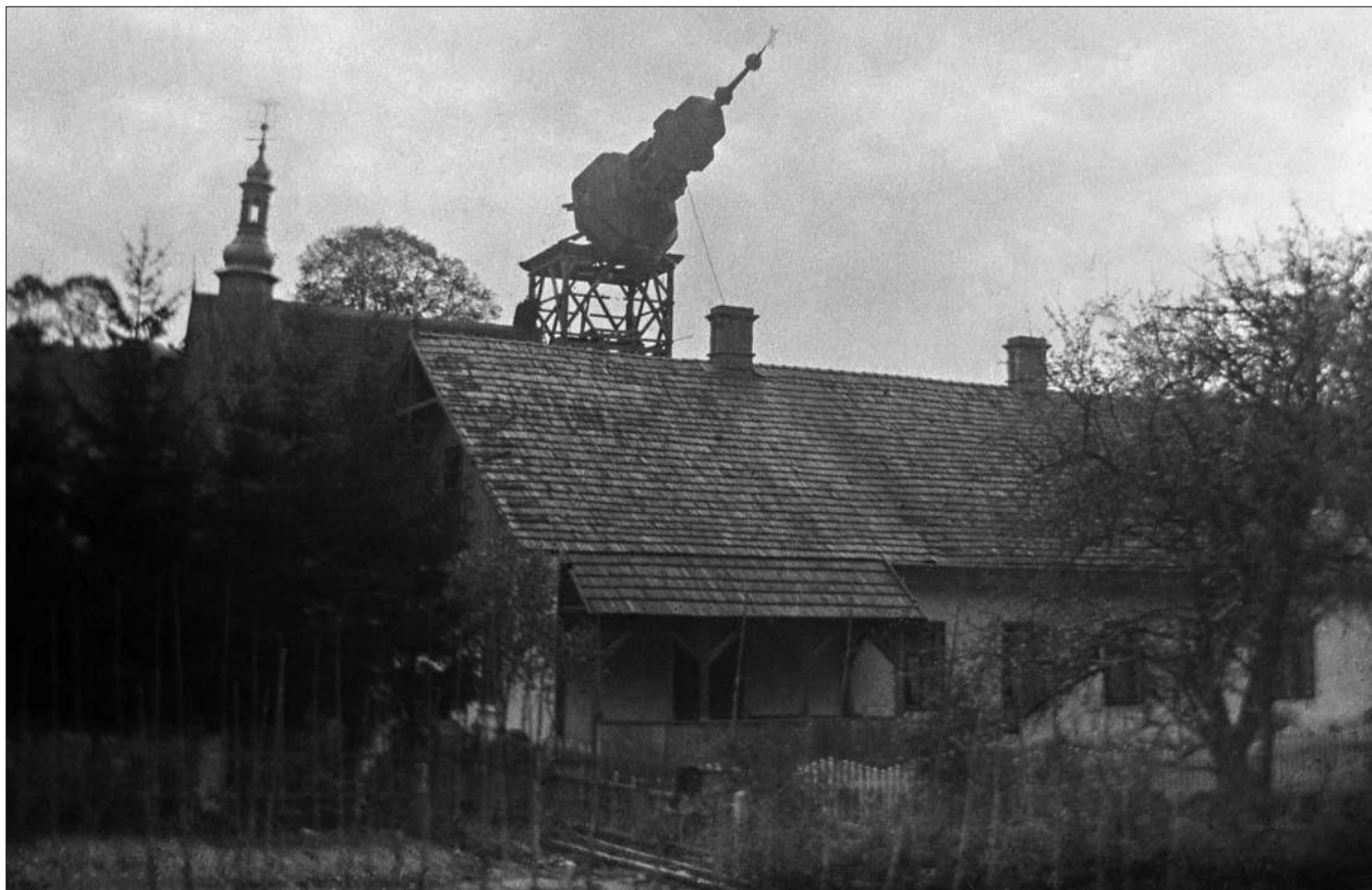
Rozbiórka w 1911 roku starego drewnianego kościoła limanowskiego, moment ściągania hełmu z wieży
