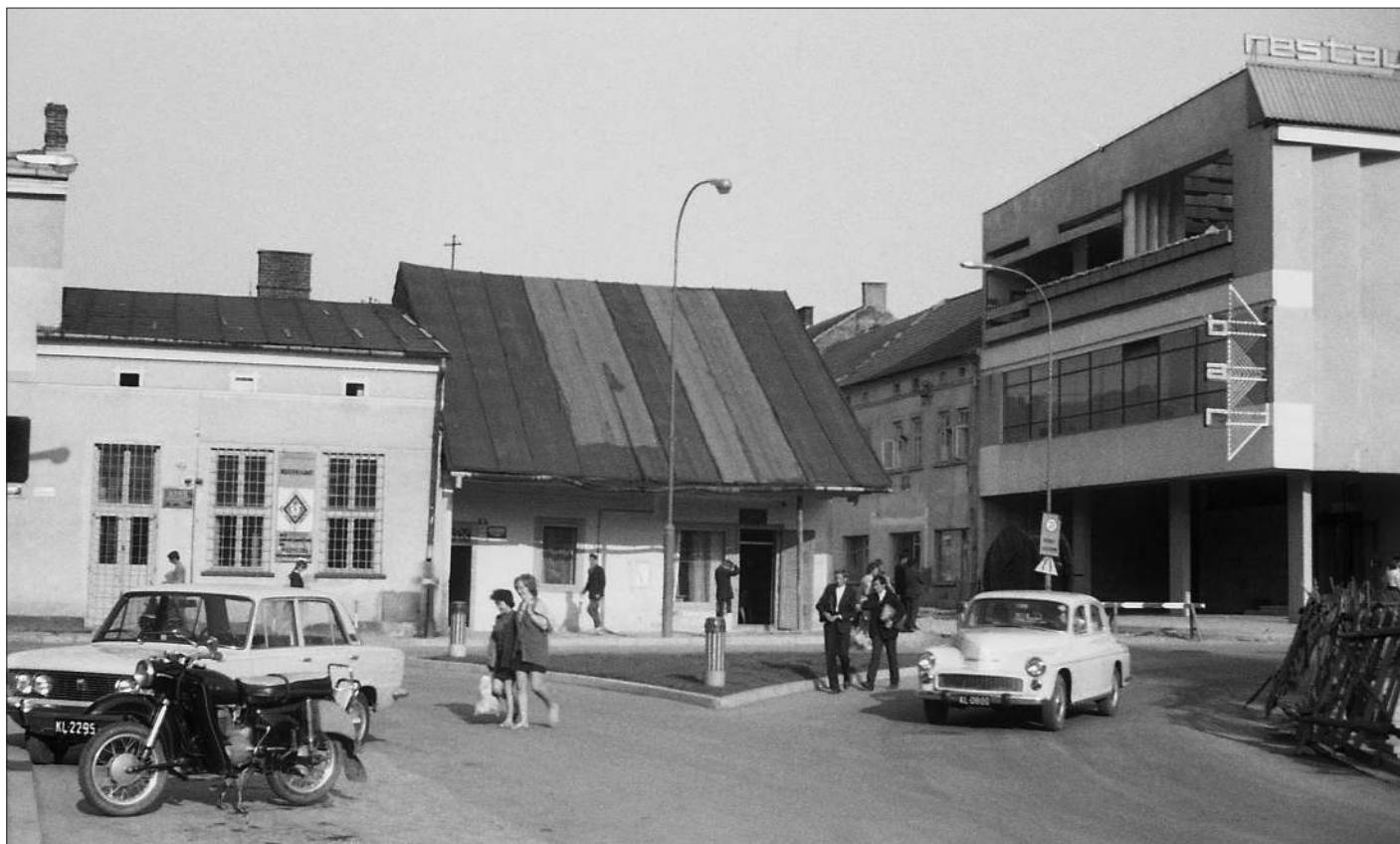
Wybudowanie baru i kawiarni „Myśliwska” przez Rejonową Spółdzielnię Zaopatrzenia i Zbytu w miejscu wyburzonych parterowych domów
