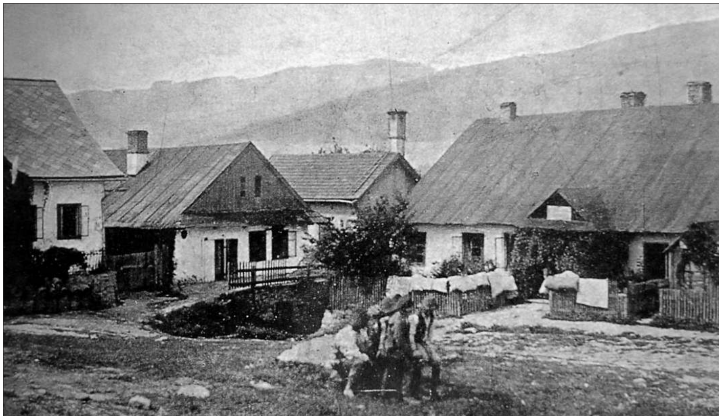
Budynki zabudowy przyrynkowej, po lewej rząd zachodniej zabudowy siedliskowej. Pierwszy budynek z lewej stał w miejscu dzisiejszej drogi powiatowej, budynek z wysokim kominem to piekarnia. Ulica ogrodowa znajdowała się w znacznie głębszym wąwozie. U jej wylotu z rynku w skarpie znajdowały się piwnice, co potwierdza powyższe zdjęcie. Piwnice istniały jeszcze w połowie XX w. Pocztówka z lat dwudziestych XX wieku (Wielek 2005; Kapturkiewicz 2025)
