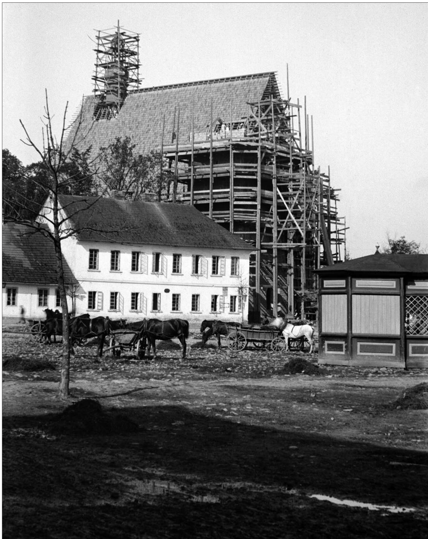
Widok na budujący się parafialny kościół limanowski z „lasem” rusztowań, po lewej budynek dawnej szkoły
