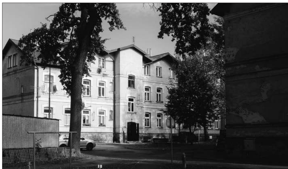
Rafineria ropy naftowej w Limanowej-Sowlinach, fot. K. Schubert, 2024. MIK, CC BY SA 4.0
