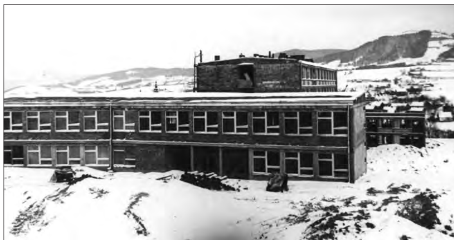
Budowa nowego obiektu szkolnego (1964 – 1966)
