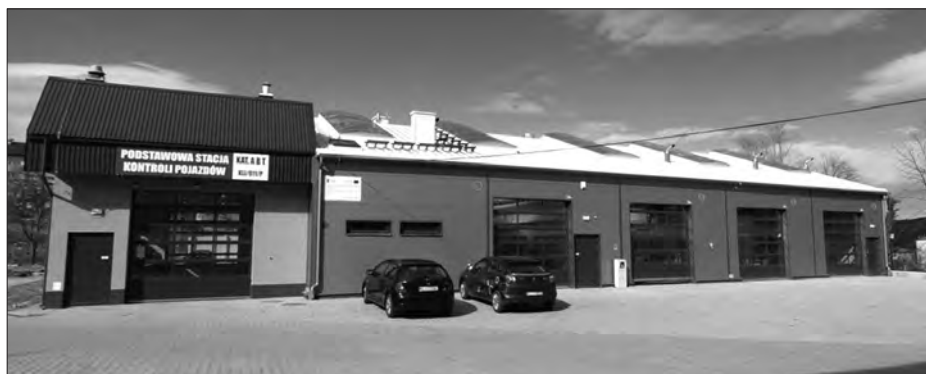
Stacja diagnostyczna i warsztaty samochodowe po modernizacji (2019 r.)
