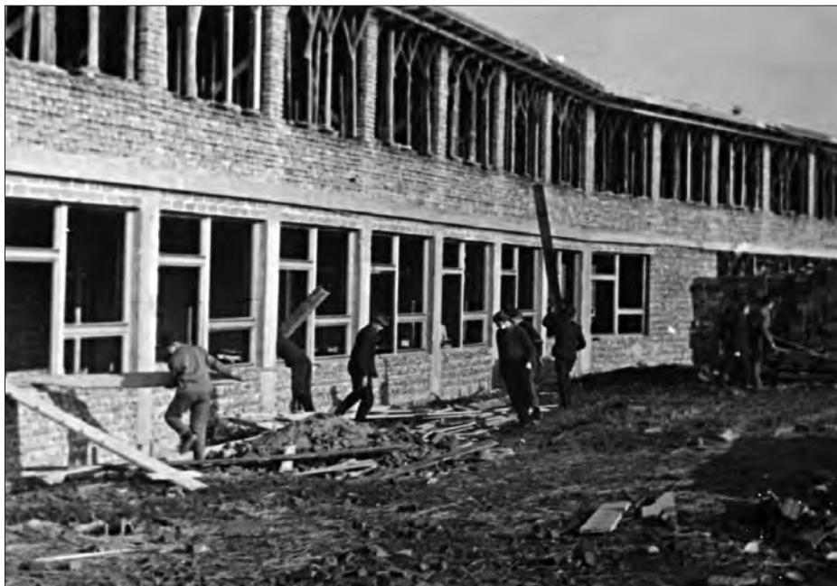
Budowa nowego obiektu szkolnego, obejmującego także warsztaty mechaniczne i internat – obecnego budynku ZSTiO (1964 – 1966)
