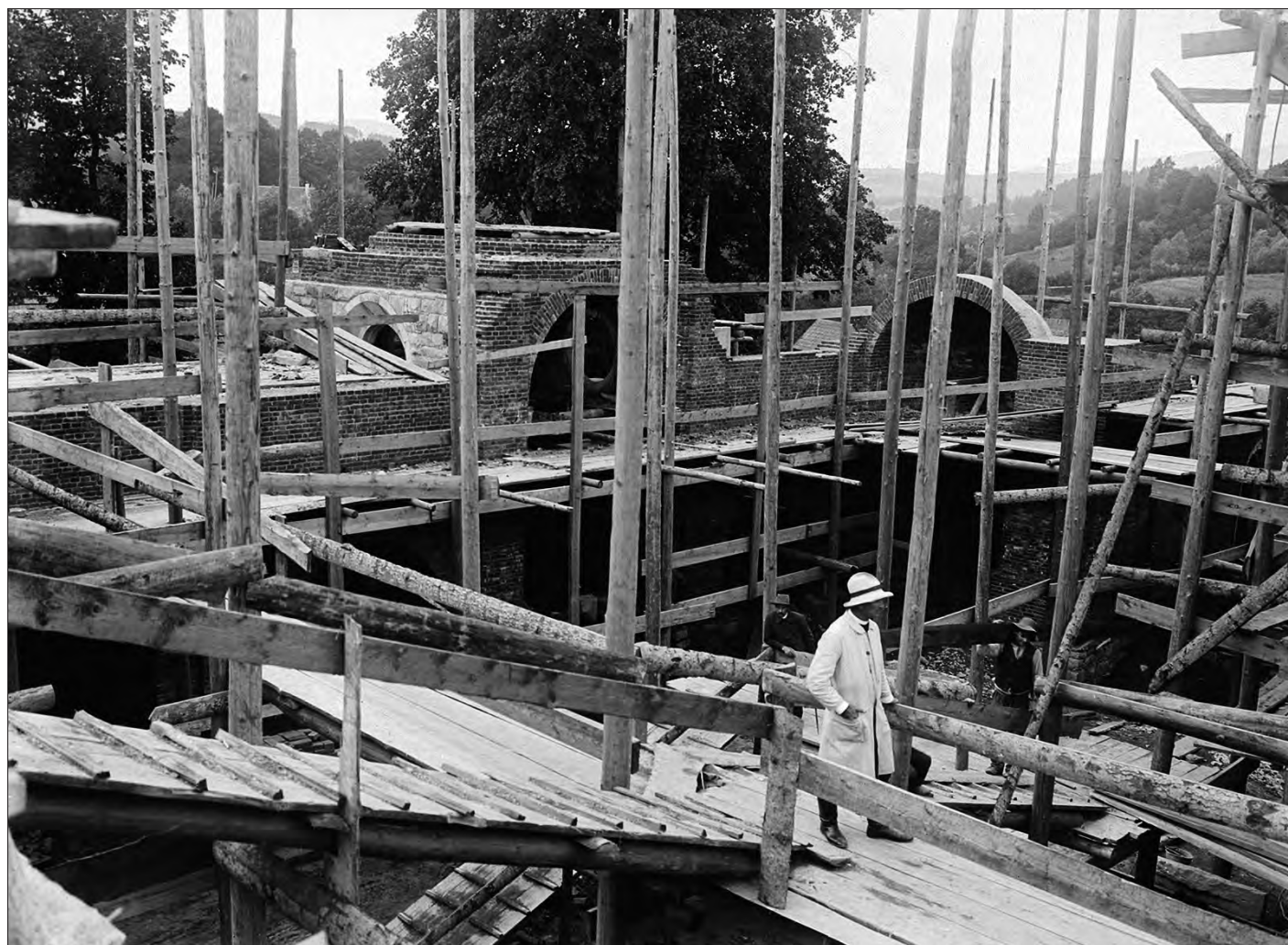
W czasie budowy kościoła w Limanowej. Rusztowania wnętrza kościoła, widok na arkady: wejściową do kaplicy Serca Jezusowego oraz ołtarza bocznego Matki Bożej Różańcowej. Na rusztowaniu na pierwszym planie budowniczy kościoła ks. Kazimierz Łazarski, za nim burmistrz Limanowej Walerian Zubrzycki. Fot. Klementyna Zubrzycka
