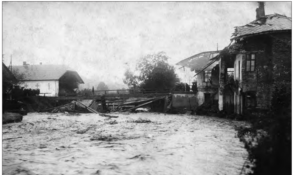
Powódź stulecia w Limanowej. Wezbrany nurt potoku Mordarka przy budynku dawnej poczty
