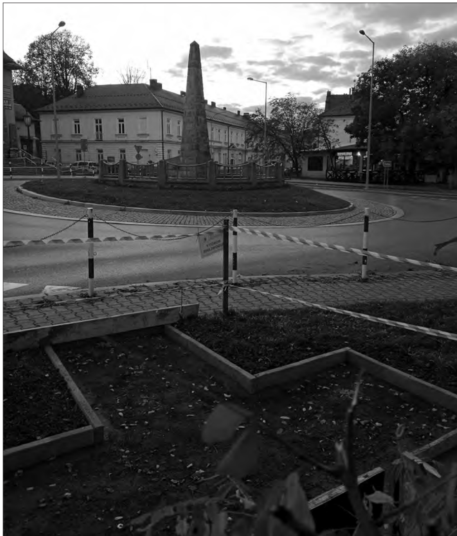
Prace ziemne małej architektury pod tablice informacyjno-edukacyjne wykonała firma FHUB Adriana Króla z Limanowej. Widok w kierunku pomnika Nieznanego Żołnierza
