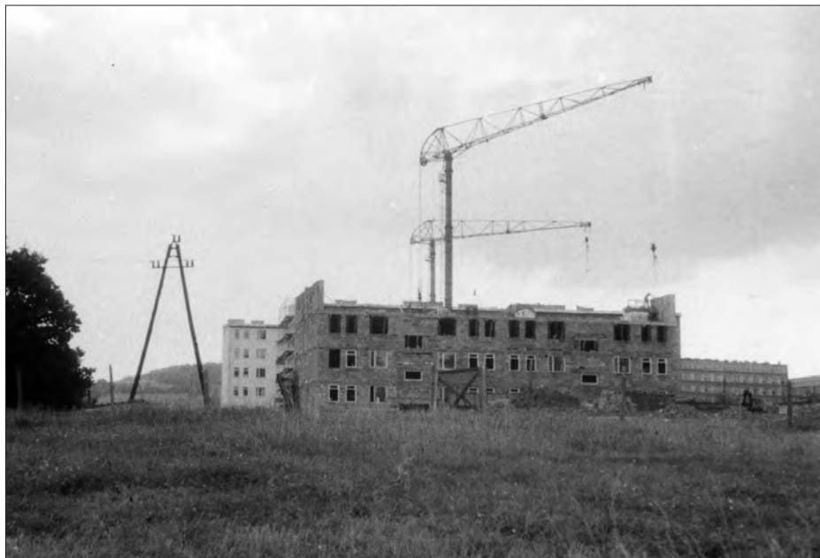
Budowa bloków na osiedlu Zygmunta Augusta
