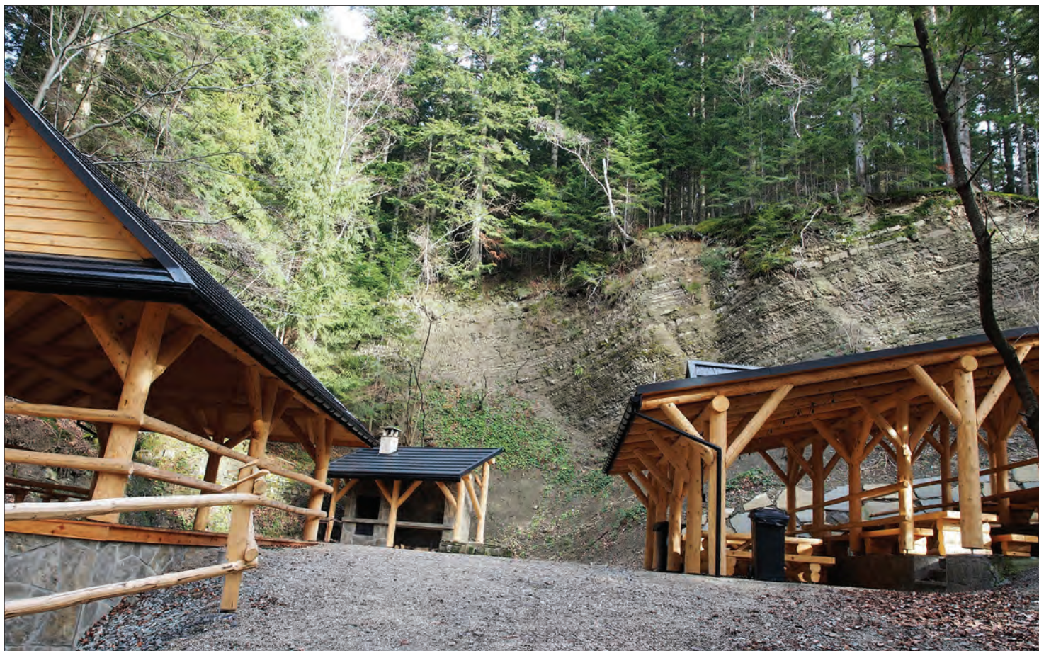
Ogólny widok placu rekreacyjno-kulturalnego w kamieniołomie pod Łysą Górą
