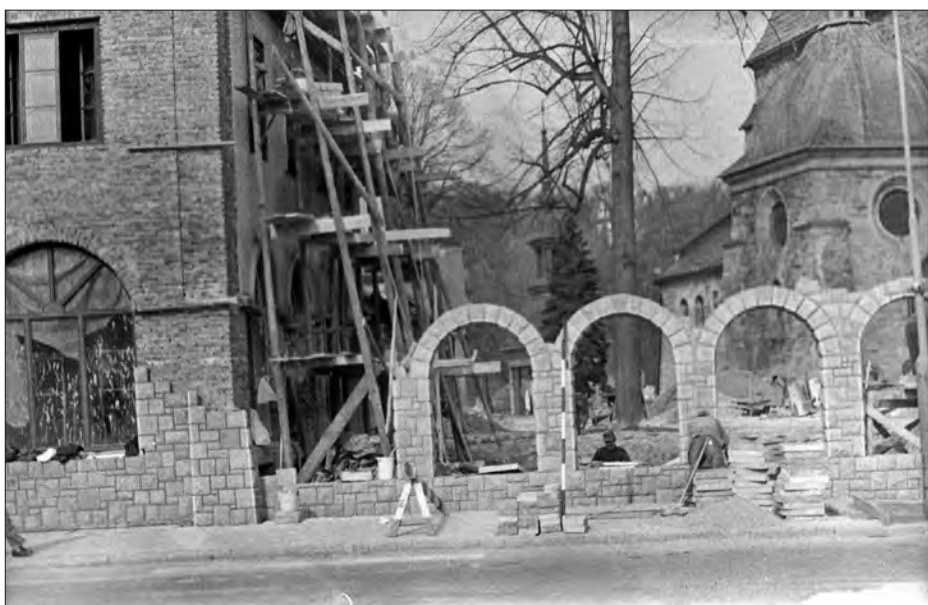
Budowa arkad po stronie zachodniej rynku
