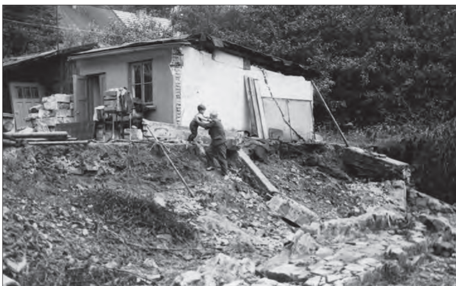
Zniszczenia po powodzi 1973 roku. Nad skarpą Włodzimierz Sułkowski. Z tyłu po lewej stronie widoczny dach pokryty papą rodzinnego domu Sułkowskich
