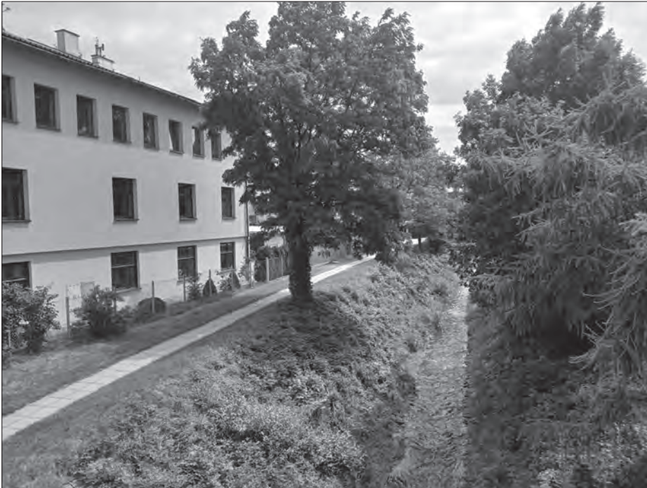
Budynek nr 40 w Limanowej przy moście na potoku Mordarka, obok wijący się wąski strumień niegroźnego potoku, który przybierał na sile w czasie powodzi Fot. Stanisław Ociepka - lipiec 2021
