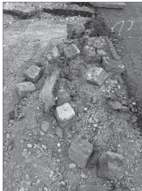
Współczesny remont drogi przy ulicy Jana Pawła II, widoczne kostki granitowe z poprzedniej drogi - lipiec 2021 r. Fot. Stanisław Ociepka
