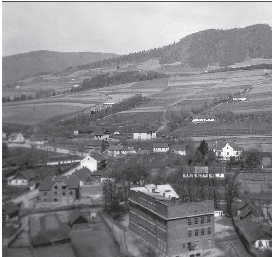
Z lewej budynek nr 40 w stanie surowym po jego odbudowie - 1938 rok
