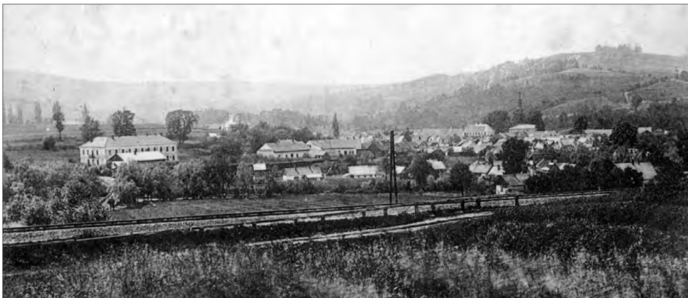
Ogólny widok Limanowej. Z lewej budynek starostwa, przed nim budynek „Sokoła” - początek XX wieku
