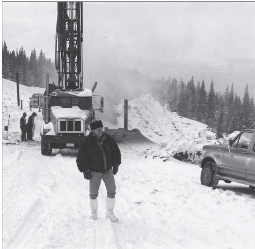
Wiercenia pod przyczółki mostu w Columbii Brytyjskiej - zima 1995/96
