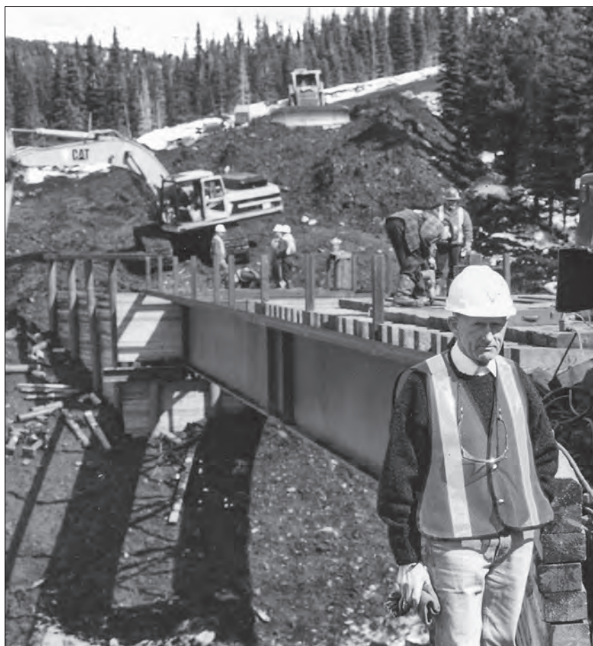
Apolinary Lach - kierownik budowy mostu w północno-wschodniej Columbii Brytyjskiej.
