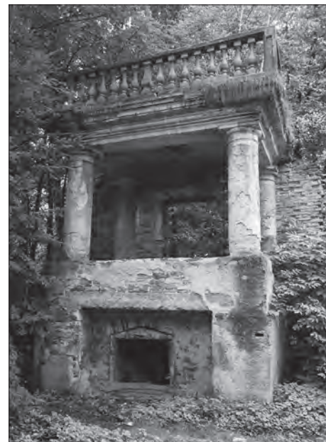
Fragment ganku z balustradą betonową
