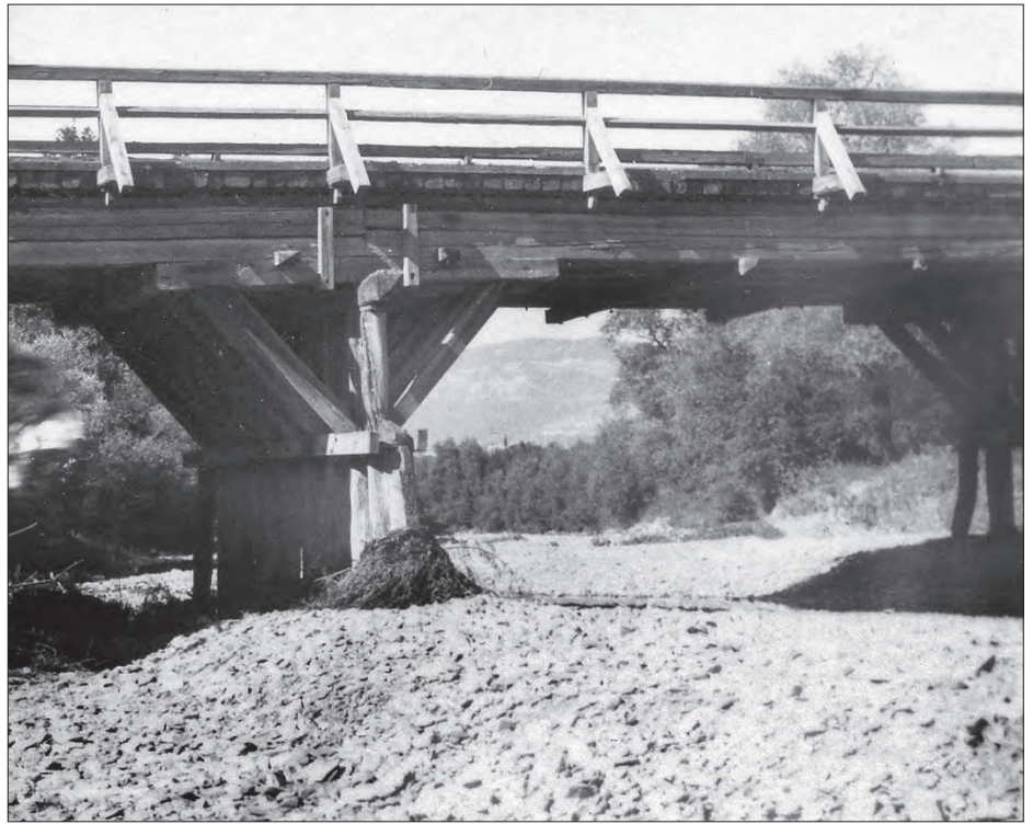
Drewniany most na rzece Sowlinka, wzdłuż ulicy Krakowskiej
