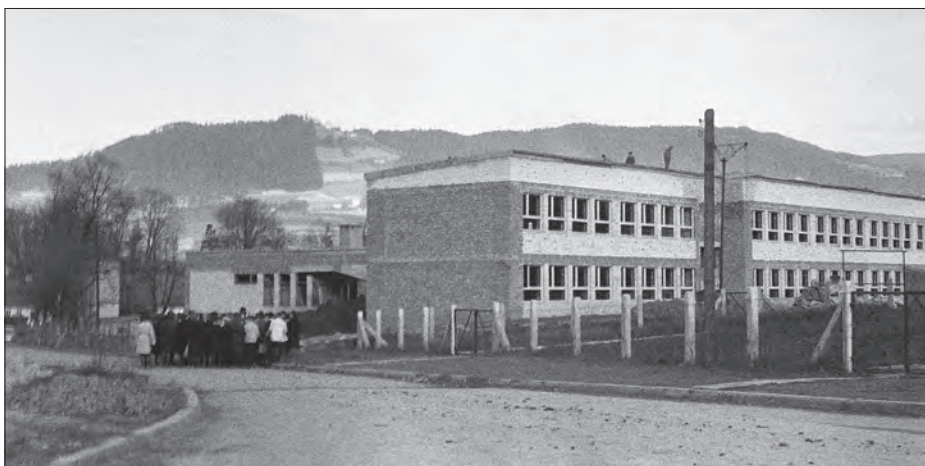
Budowa szkoły na osiedlu Zygmunta Augusta - 1965 rok.
