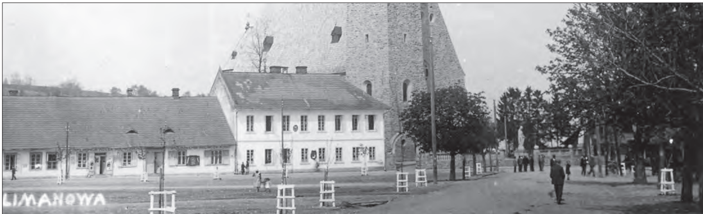
Budynek Spółdzielni Handlowej „KOSA” (z lewej) - lata międzywojenne.
