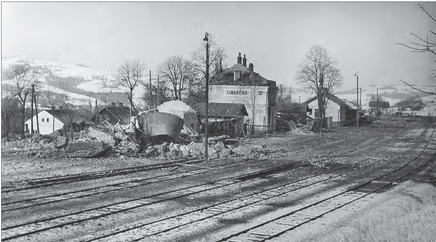
Budynek stacji kolejowej w Limanowej zniszczony przez wycofujące się wojska niemieckie.
