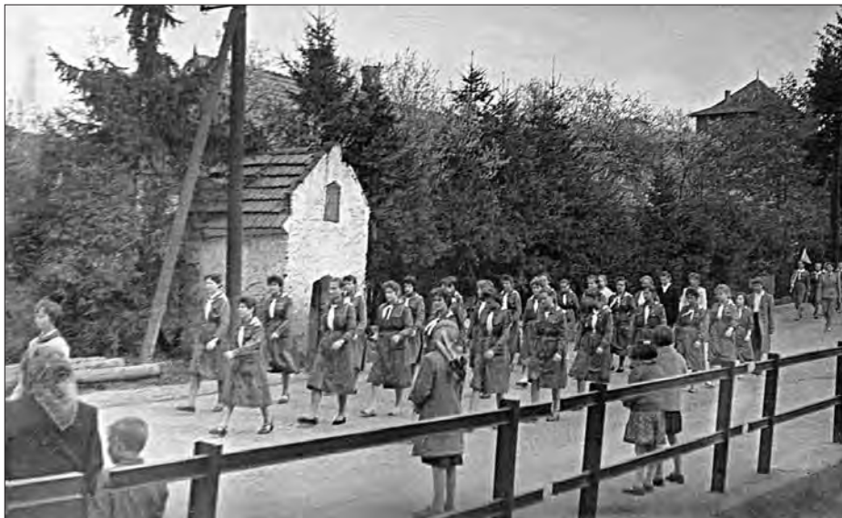
Kapliczka pw. św. Jana Nepomucena usytuowana przy ul. Świerczewskiego, przed mostem na potoku Mordarka naprzeciw budynku starej poczty – lata sześćdziesiąte XX wieku
