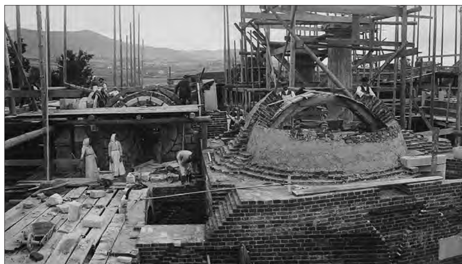
Budowa limanowskiej świątyni. W tle widoczna Łysa Góra – 1912 r.
