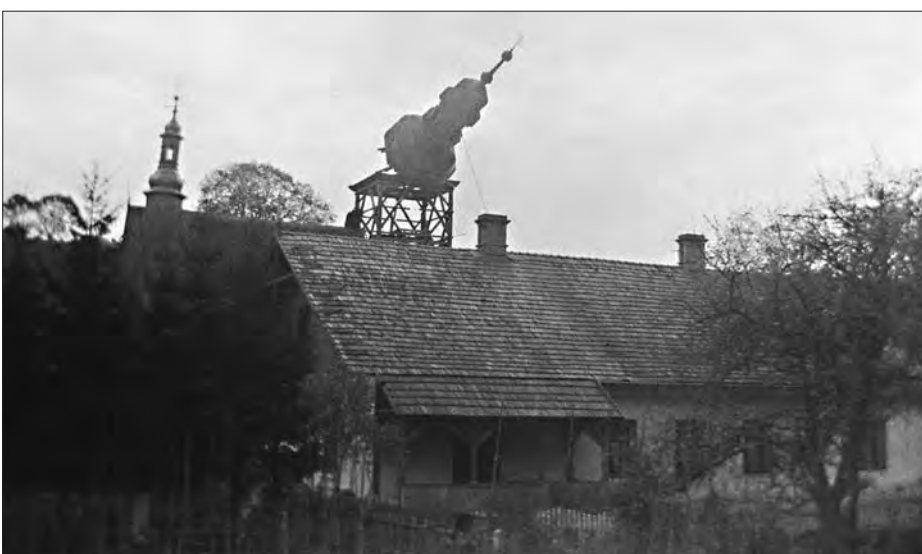
Rozbiórka drugiego, drewnianego kościoła w Limanowej – 1909 r.
