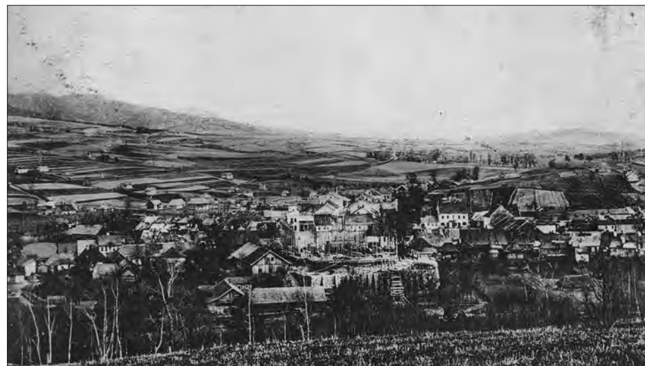
Plac budowy kościoła w Limanowej. Pośrodku widoczne fundamenty świątyni – 1911 r.
