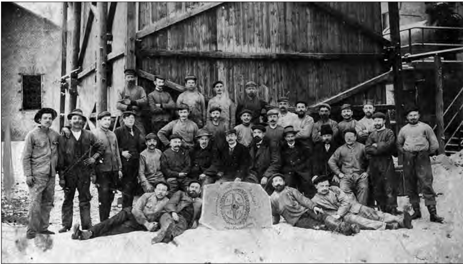
Budownicy rafinerii nafty w Sowlinach – 1908 r.
