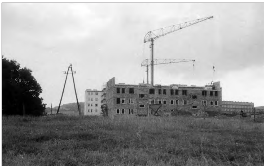
Tak miasto wkraczało na pola uprawne – budowa kolejnych bloków mieszkalnych przyszłego Osiedla Dworskiego
