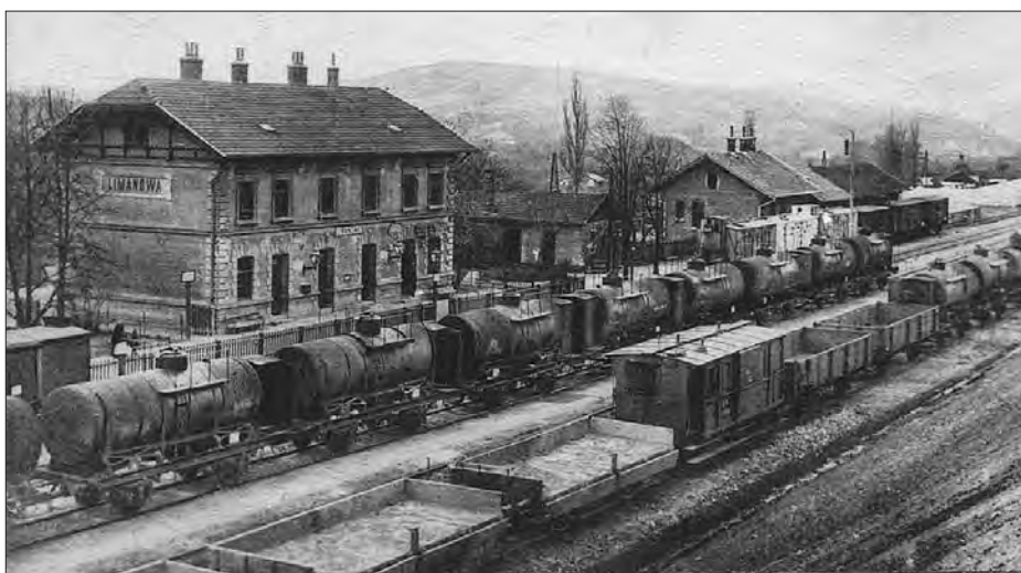
Stacja kolejowa w Limanowej na trasie transwersalnej kolei Chabówka - Nowy Sącz
