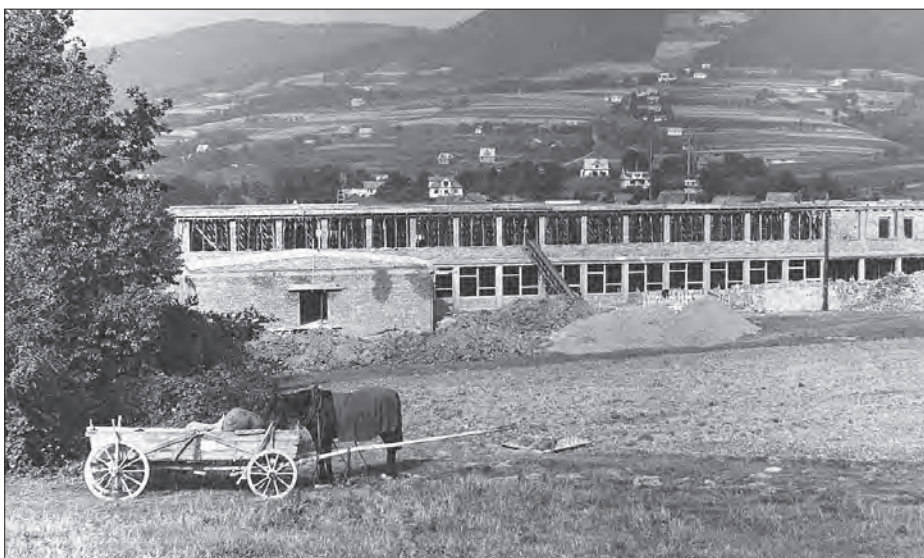
Budowa Zespołu Szkół Mechaniczno-Elektrycznych i towarzyszące prace polowe na przyległych polach
