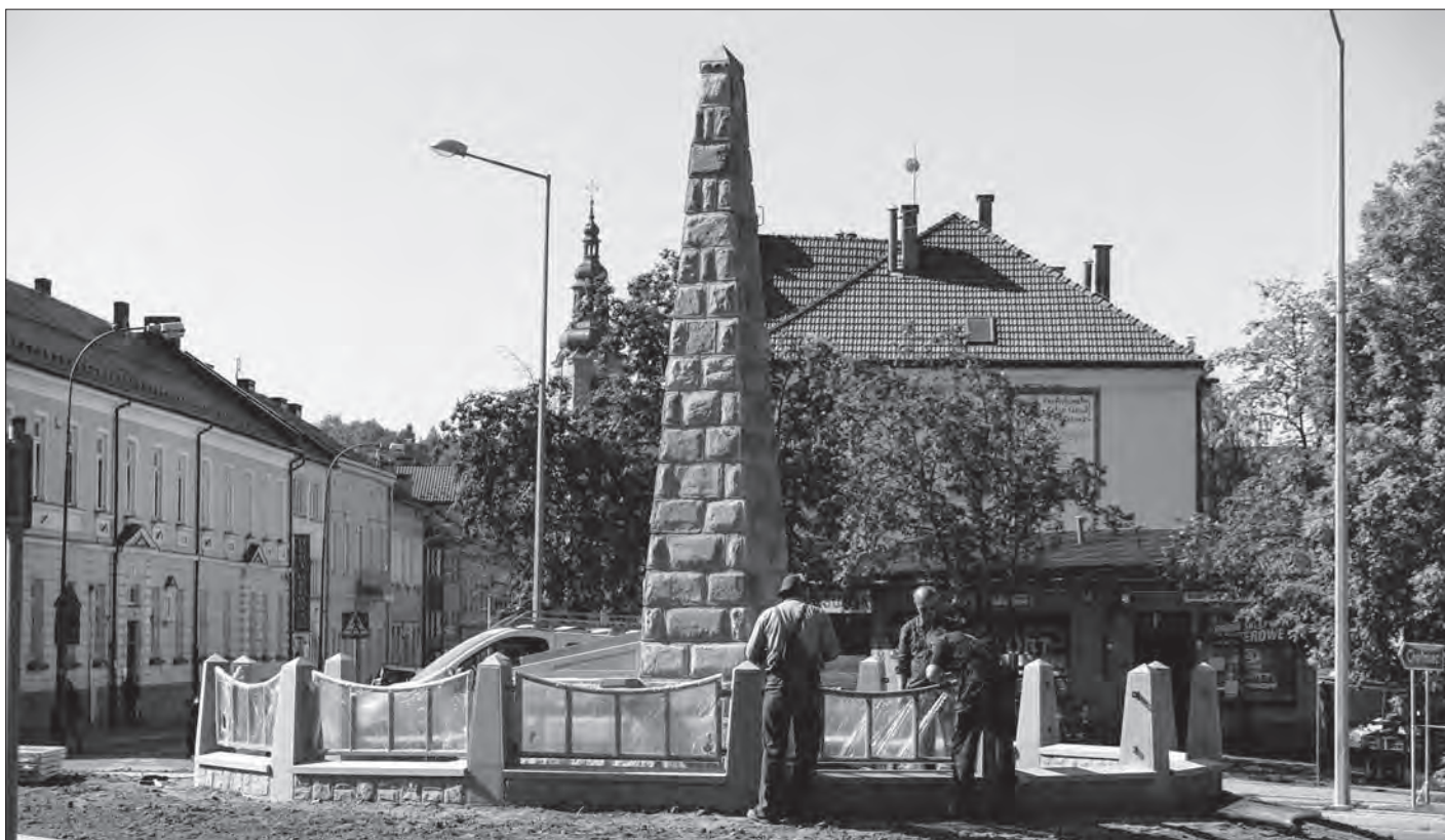
Montaż stylizowanego ogrodzenia wokół pomnika przez firmę „Instal” - 17 września 2014r.
