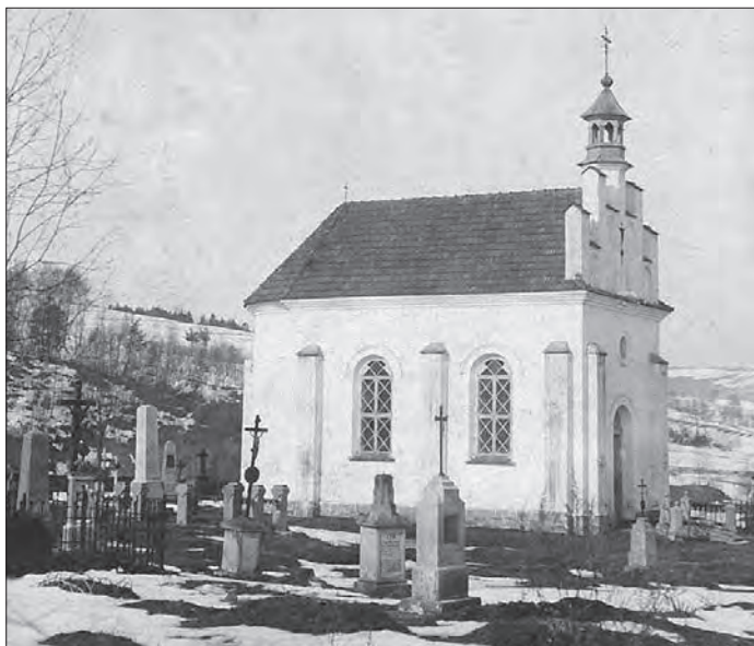
Pierwotny wygląd elewacji południowej kaplicy
