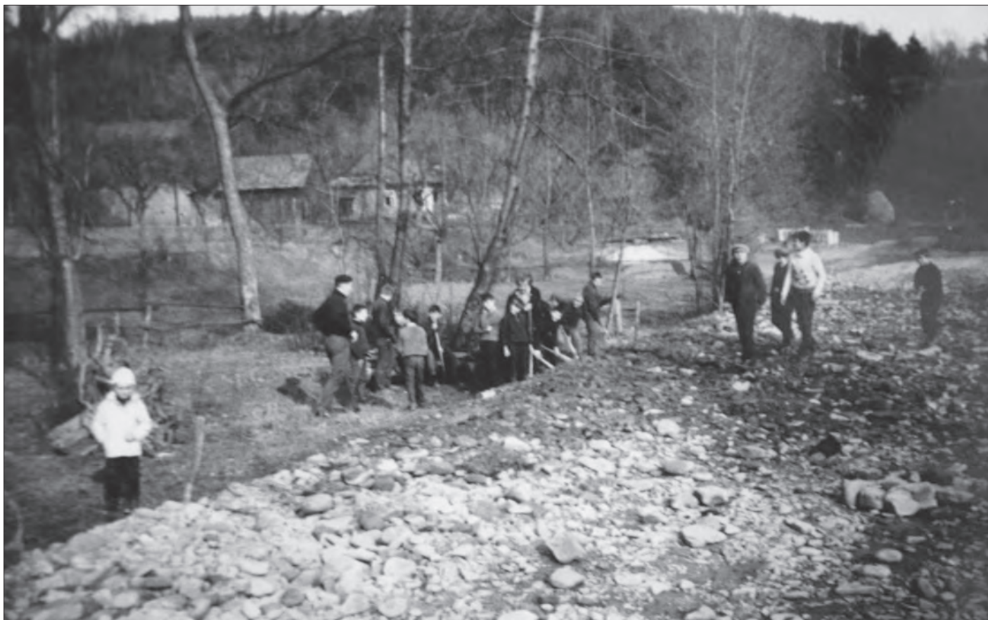
Uczniowie przy budowie drogi z Dobrej do Tymbarku, 1970 r.
