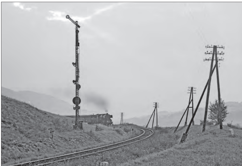
Wyjątkowo wysoki semafor wjazdowy od strony Marcinkowic
