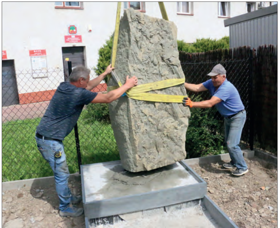
Montaż głazu na postumencie
