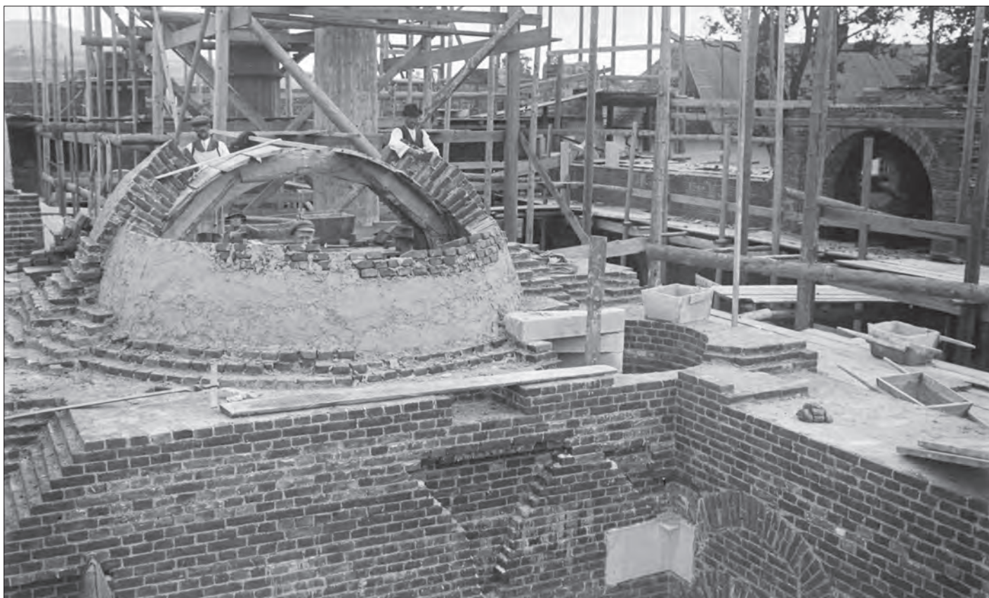
Podstawowym materiałem budowlanym limanowskiego kościoła była cegła z cegielni w Sowlinach - fotografia z 1912 roku Klementyny Zubrzyckiej
