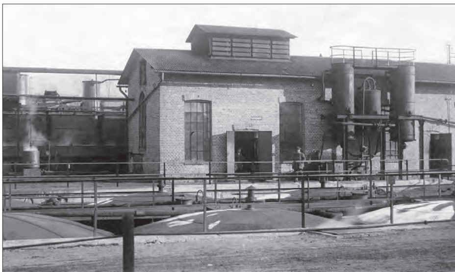
Zabudowania techniczne Rafinerii Nafty w Sowlinach
