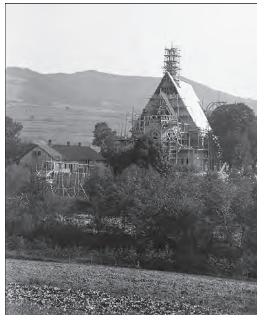
Widok od strony Potoku Starowiejskiego na budowany kościół limanowski, tuż po zakończeniu pracy przy wieżbie dachowej nad prezbiterium. W tle panorama Łysej Góry
