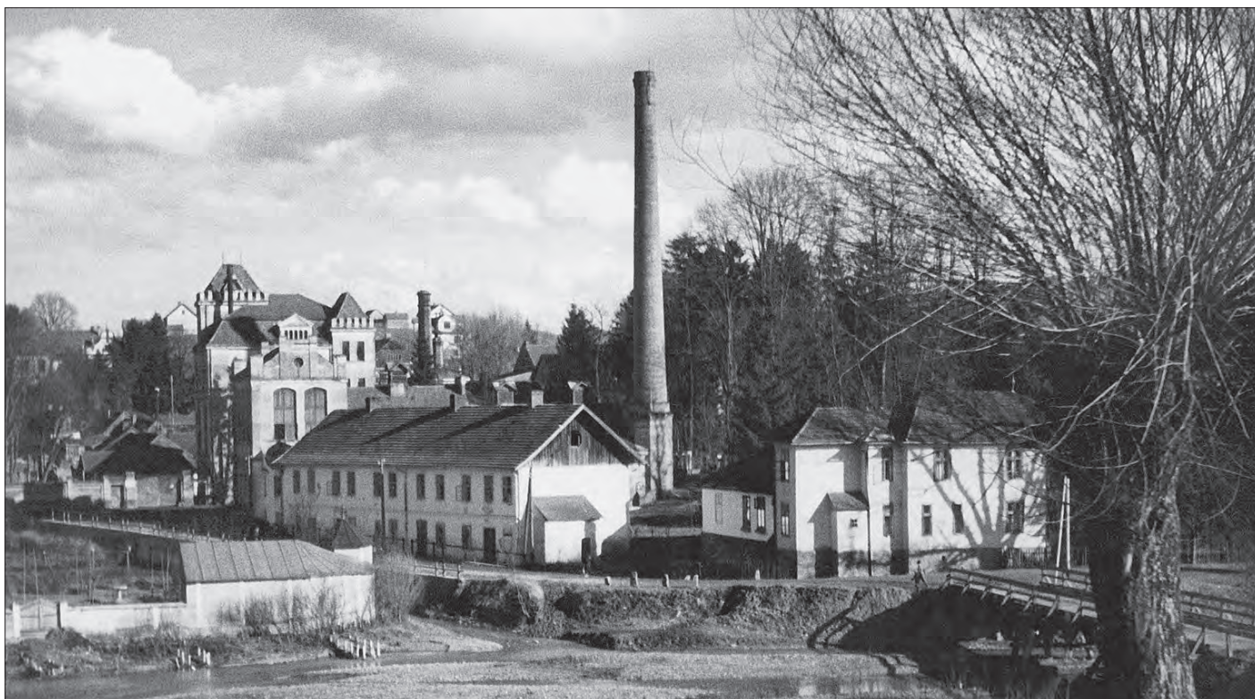
Ogólny widok ceglano komina browaru w Limanowej. Fotografia z lat międzywojennych
