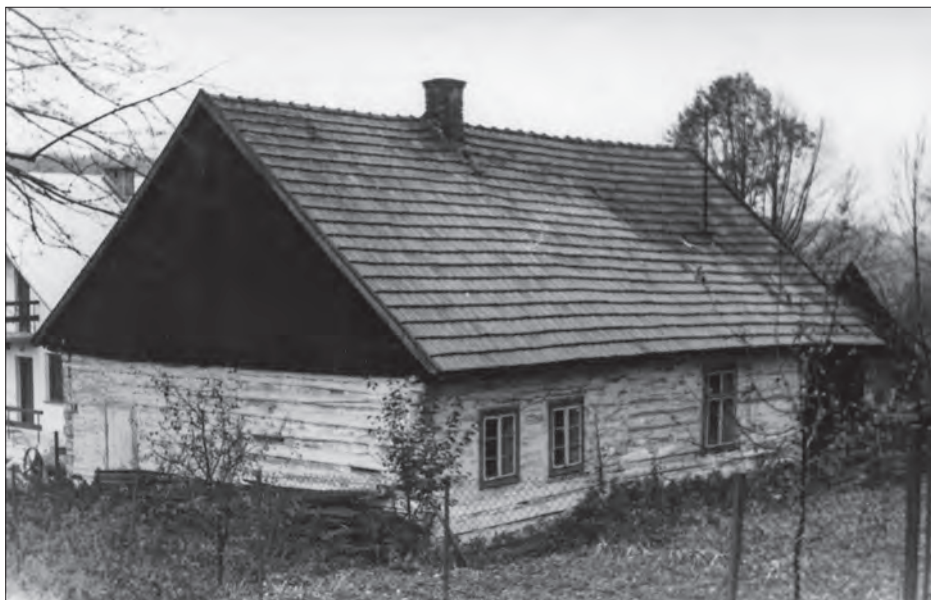
Dom rodzinny Jasiców „Pod stacją”, dziadków Krystyny
