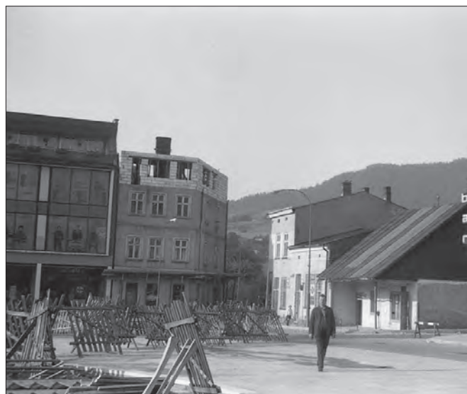
Dobudowa trzeciego piętra na dwukondygnacyjnej kamienicy Tomasza Biela - 1971 rok
