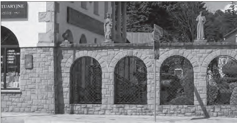
Końcowy efekt montażu pamiątkowej tablicy na ścianie księgarni „Verbum”
