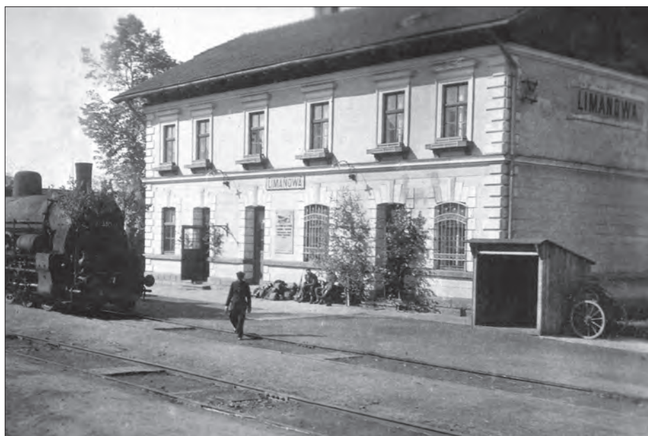
Staraniem Zarządu Ogniska KPW Limanowa została ufundowana tablica upamiętniająca kpt. Franciszka Żwirko i inż. Stanisława Wigurę. Tablicę wmurowano na frontowej ścianie budynku stacyjnego 11.11.1934 r.
