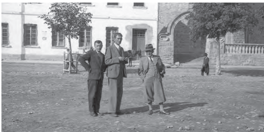
Poniżej: W czasie remontu elewacji budynku szkoły w latach międzywojennych tablica została zdemonstrowana - na zdjęciu widoczny ślad po tablicy
