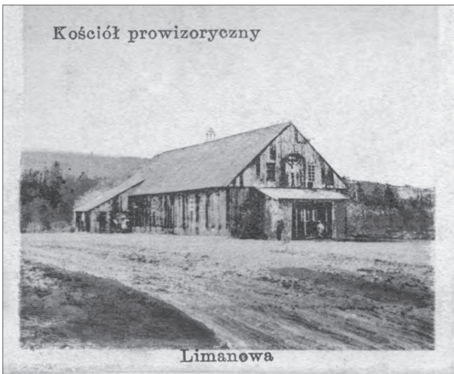
Prowizoryczna kaplica wybudowana z materiałów rozebranego w 1910 roku drewnianego kościoła. Kaplica znajdowała się przy ul. Szwedzkiej obok cmentarza parafialnego i służyła parafii do czasu ukończenia budowy nowej świątyni w 1918 roku.
