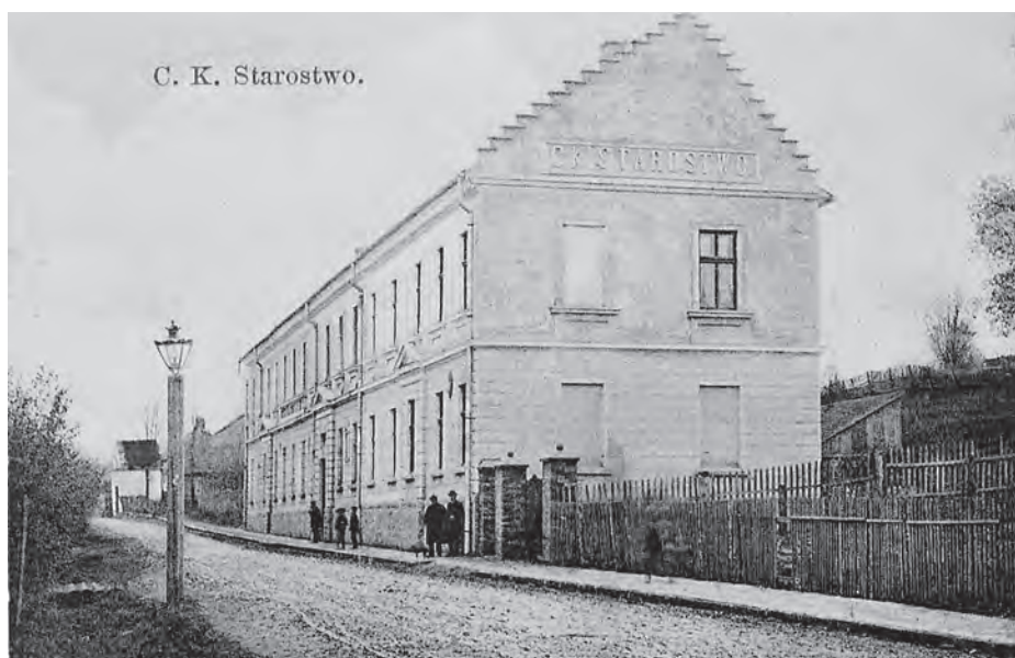
Powyżej: Budynek Starostwa na początku XX wieku przy ulicy Waleriana Zubrzyckiego.
