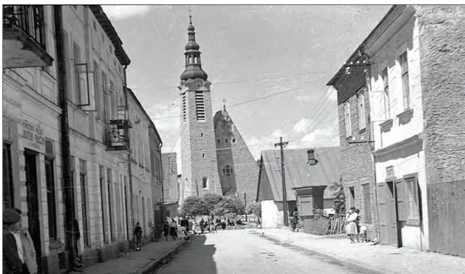
Sklep Waclawa Baluty (z prawej, nieotynkowany budynek) przy ulicy Orkana.
