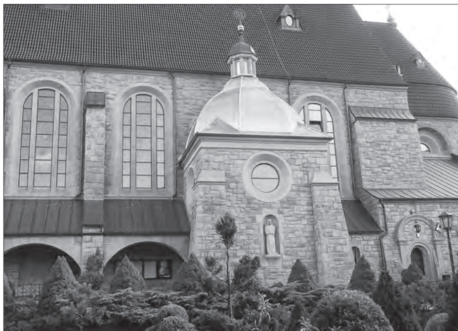
Kaplica św. Antoniego z nowym pokryciem dachowym.
