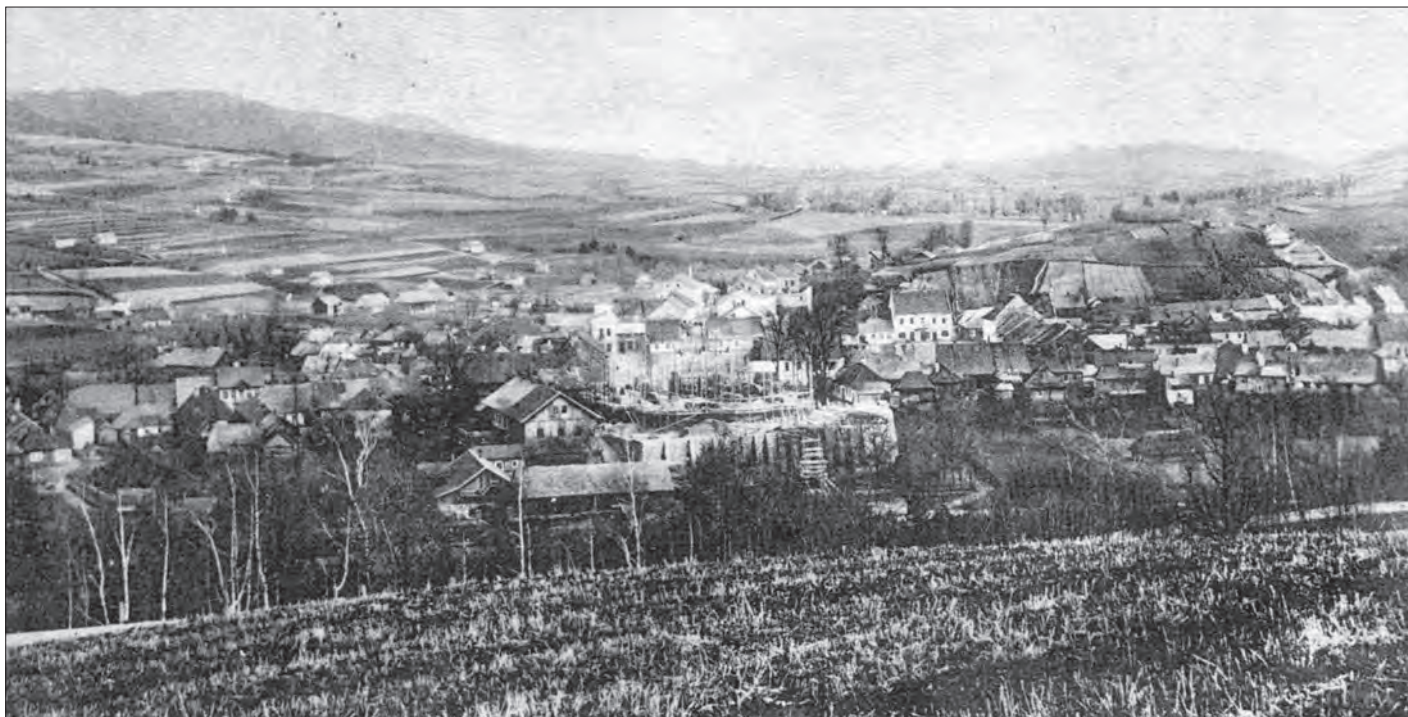
Ogólny widok Limanowej. Pośrodku widoczny plac budowy kościoła (fundamenty) - 1912 rok.
