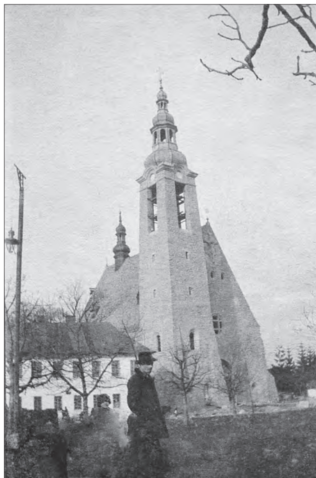
Stan surowy kościoła - 1919 rok.
