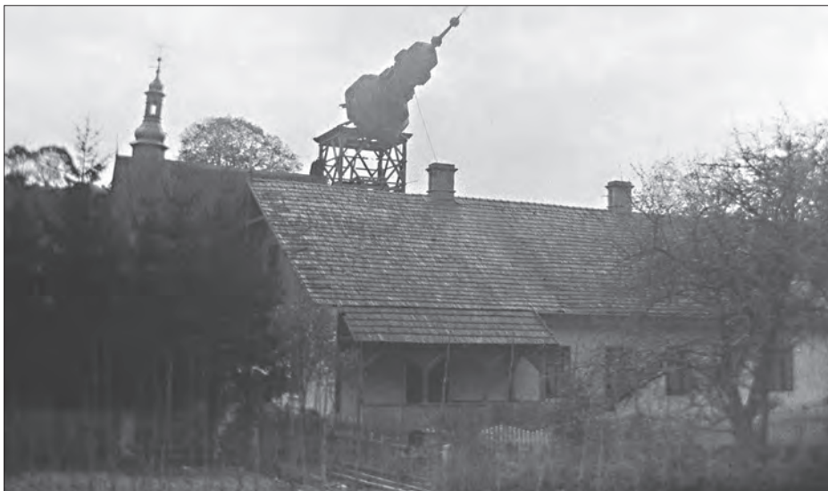
Rozbiórka starego drewnianego kościoła limanowskiego w 1910 roku - moment ściągania helmu z wieży. Fot. Klementyna Zubrzycka.
