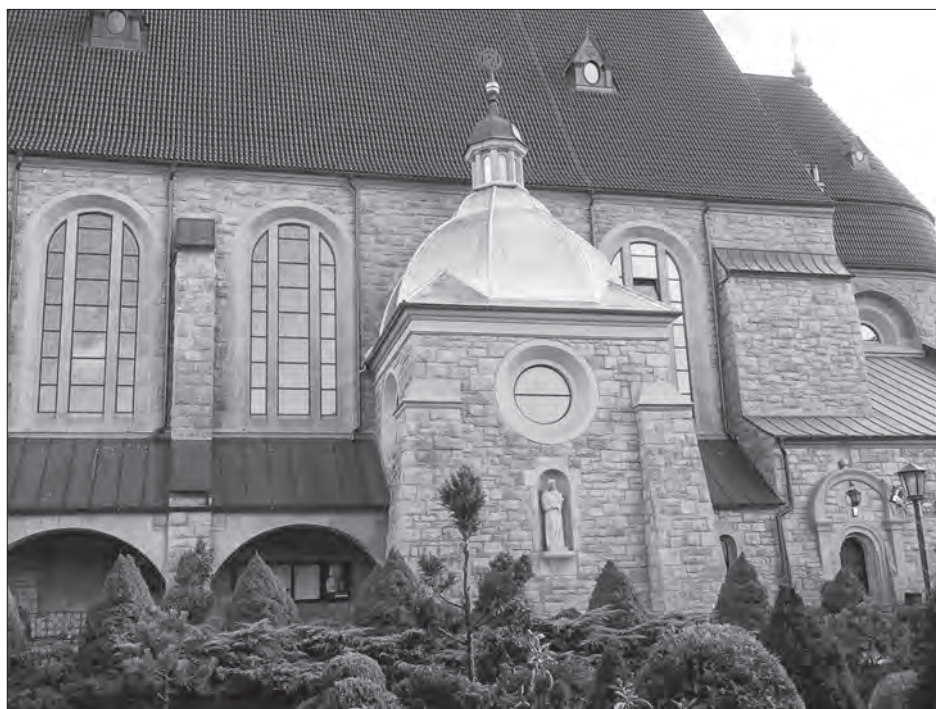
Pokrycie kopuły blachą miedzianą (imitacja karpiej łuski) - sierpień 2017 r.
