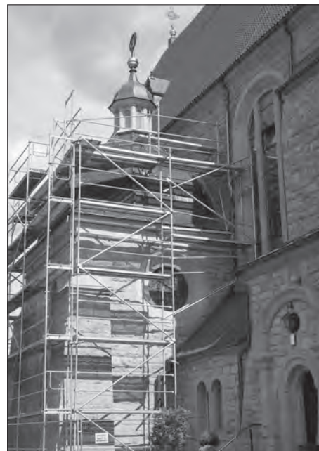
Kaplica św. Antoniego przed zmianą pokrycia kopuły.
