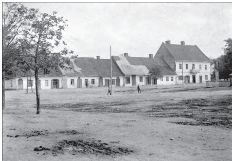
Pierzeja wschodnia limanowskiego rynku - początek ubiegłego stulecia.
