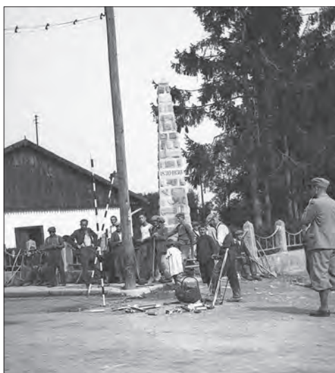
Obok: Przejście wodociągu pod torami kolejowymi w okolicy jaru (dzisiaj przy ul. Źródlanej).
