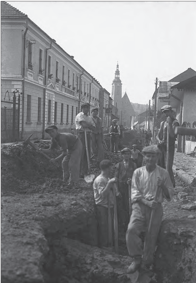
Wykopy pod wodociąg na ulicy Józefa Piłsudskiego (dzisiaj M. B. Bolesnej). Z lewej kamienica starostwa, z prawej parterowy budynek „Sokoła”.
