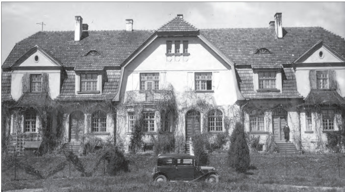
Willa dla kadry inżynierskiej rafinerii nafty w Sowlinach przy ul. Krakowskiej. Fotografia z lat międzywojennych.
