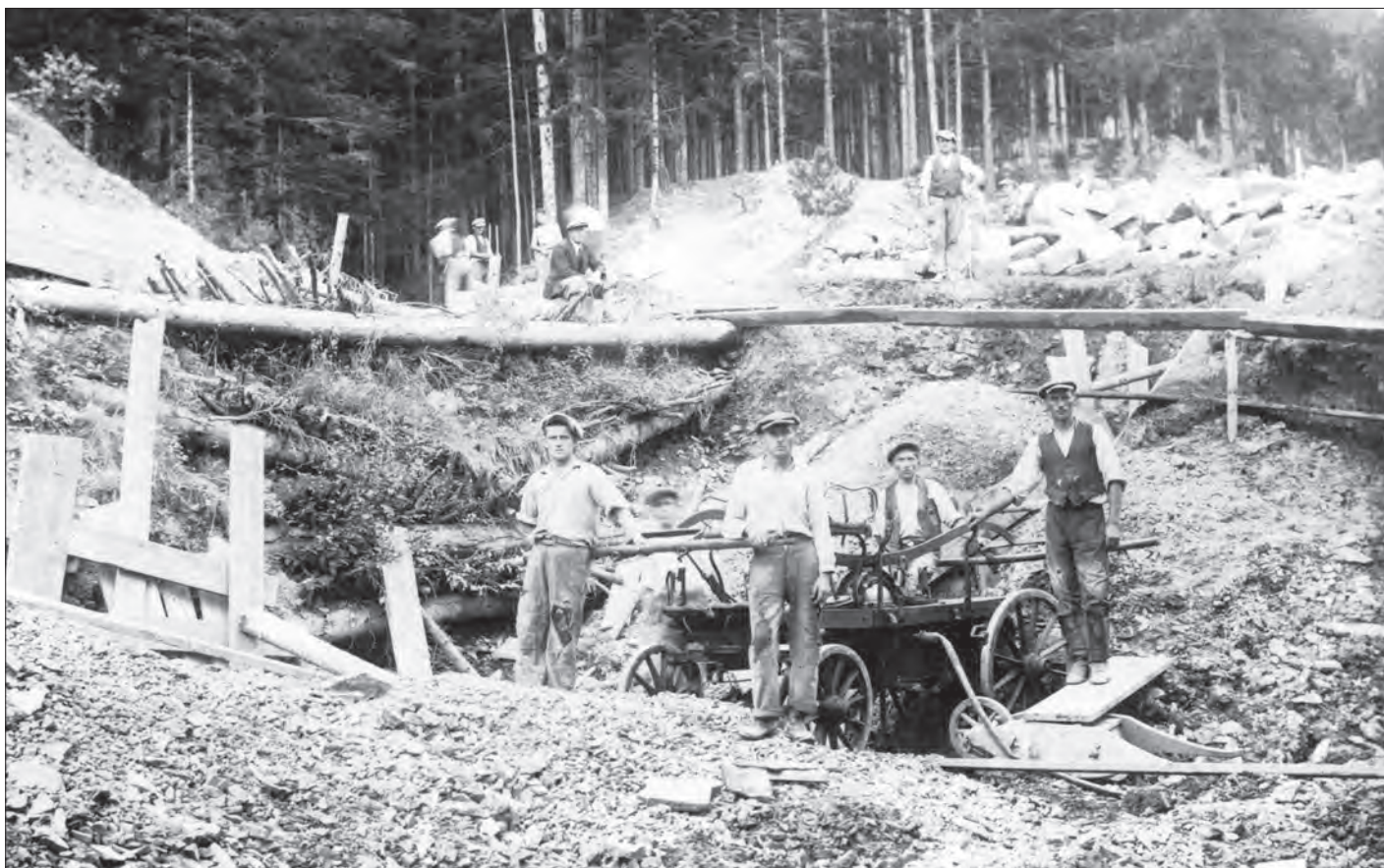
Budowa głównego zbiornika ujęcia wody w Wielkiej Dolinie pod Łysą Górą - 1936 rok.
