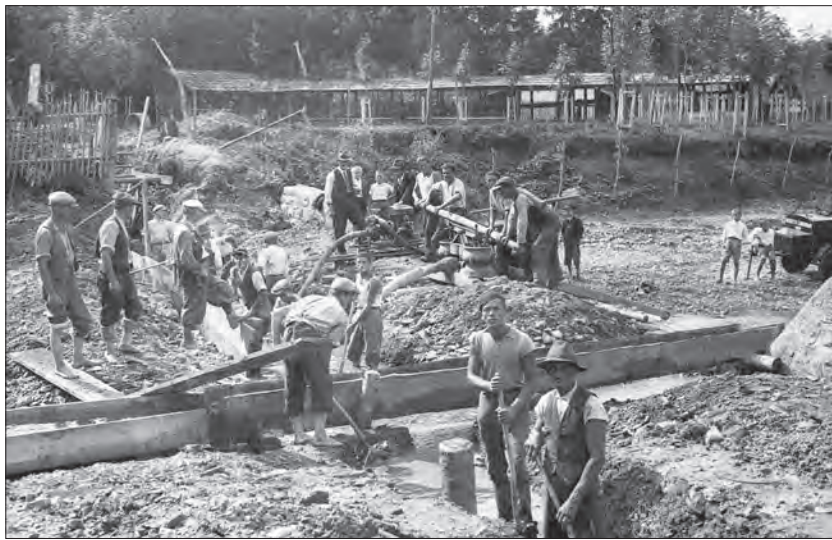
Regulacja potoku Mordarka po powodzi stulecia w 1934 r. na wysokości placu sportowego „Sokoła”. W głębi zabudowania kręgielni - 1935 rok.
