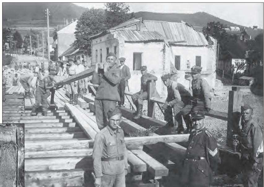
Końcowe prace budowy drewnianego mostu. Z prawej zniszczony przez powódź budynek dawnej poczty.
