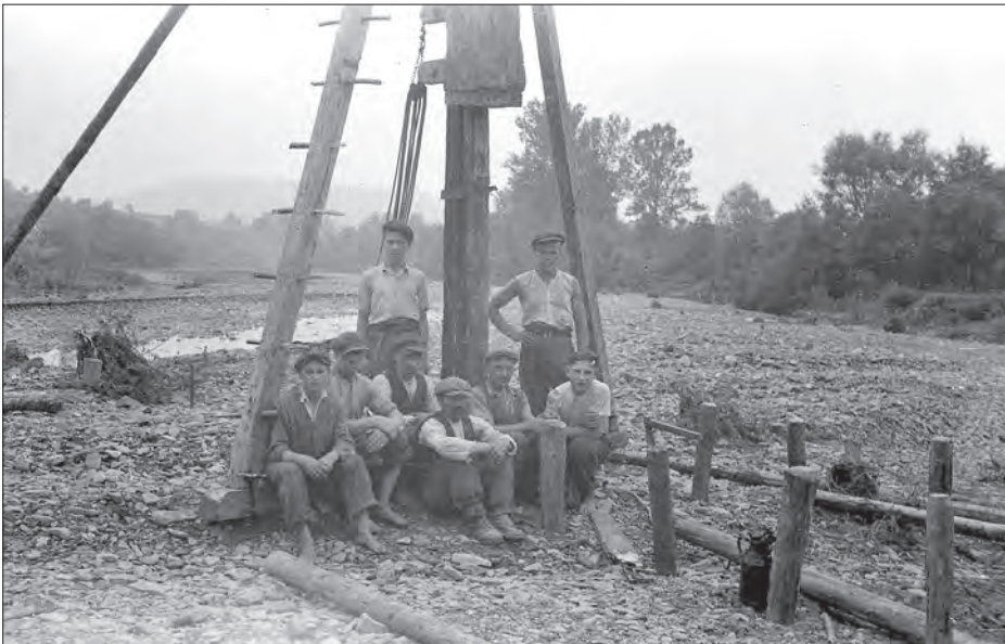
Prace przy ochronnej ostrodze brzegowej w górnym odcinku koryta Sowlinki.
