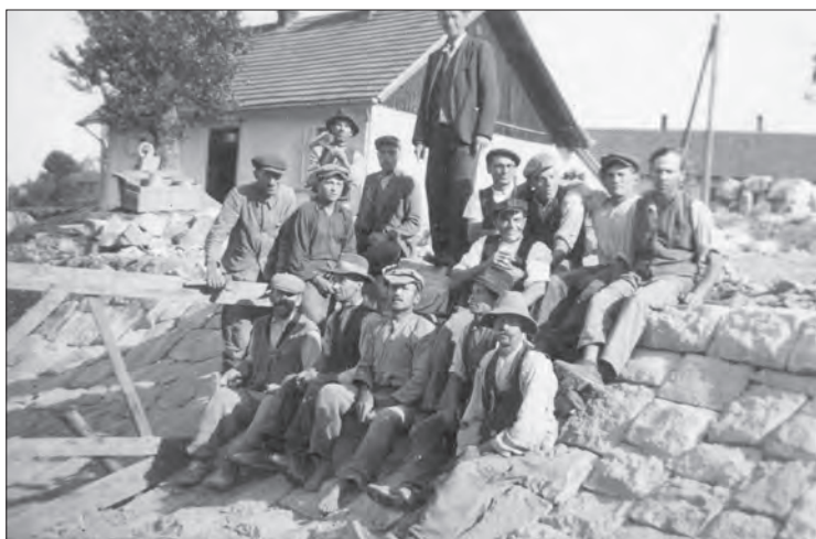
Brygada kamieniarzy wykonujących prace regulacyjne potoku Mordarka - 1941 rok.
