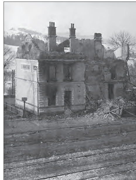
Budynek stacji kolejowej w Limanowej zniszczony przez wycofujących się Niemców w 1945 roku.
