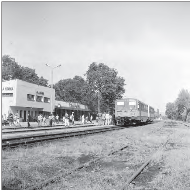
Stacja kolejowa w latach siedemdziesiątych XX wieku.
