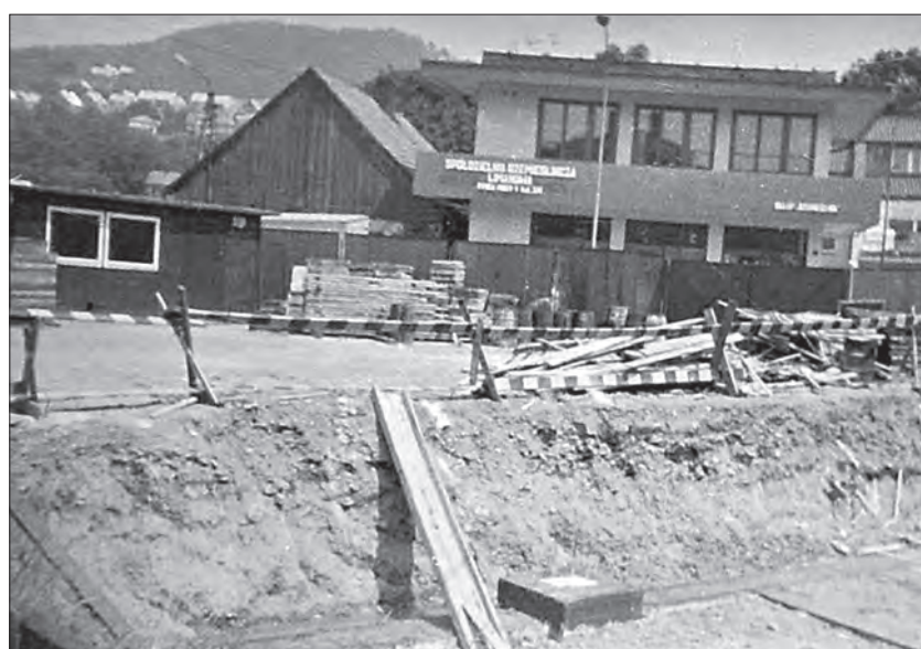
Budowa nowej siedziby banku - rok 1988.
