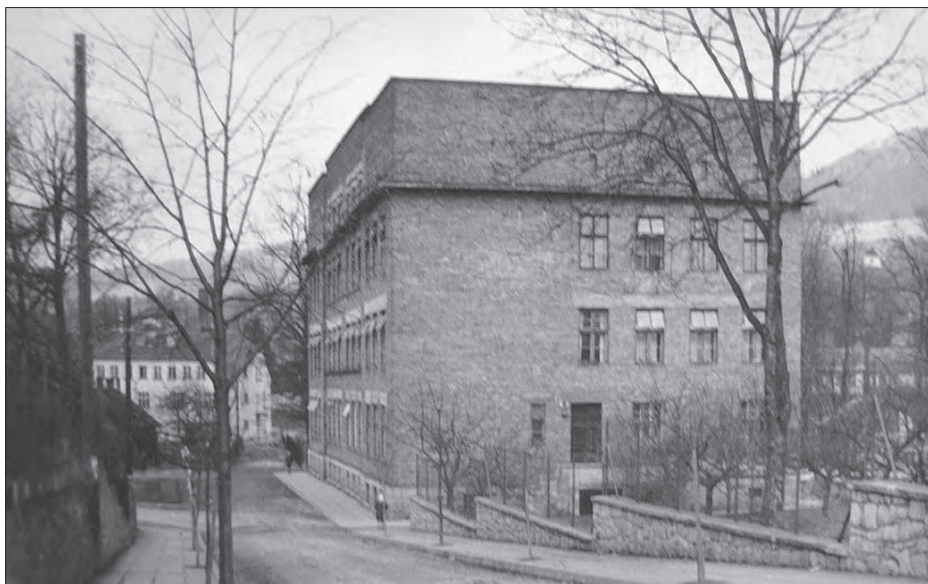
Radiowęzeł mieścił się w budynku poczty (w głębi po lewej) przy ulicy Krakowskiej.
