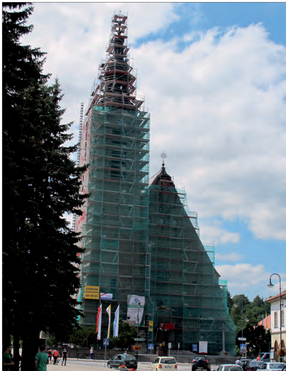
Powyżej: Rusztowania na zewnętrznej elewacji kościoła - 2013 rok.
