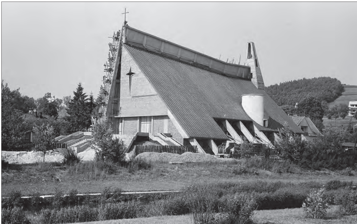
Kościół w Sowlinach w stanie surowym. [Fot. Zbigniew Dutka]
