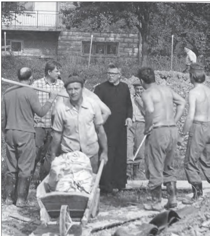
Ks. Jan Bukowiec wraz z parafianami, społecznie pracującymi przy robotach ziemnych. [Fot. Józef Staniszewski]
