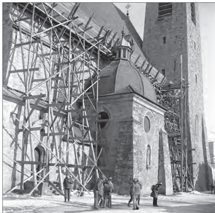
W latach 1980-1984 przeprowadzono gruntowną renowację limanowskiego kościoła, m.in.: wymieniona została drewniana konstrukcja dachu oraz zniszczone pokrycie, które uzupełniono dachówką z daszków pulpitowych. Te pokryto z kolei miedzianą blachą. [Fot. Józef Staniszewski]
