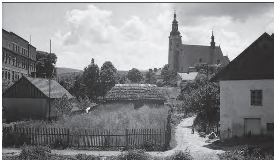
Otoczenie budynku szkoły od zachodniej strony - lata trzydzieste XX wieku.
