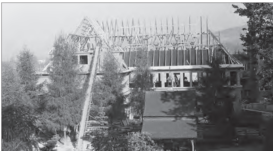
Budowa Domu Pielgrzyma. [Fot. Zbigniew Dutka]
