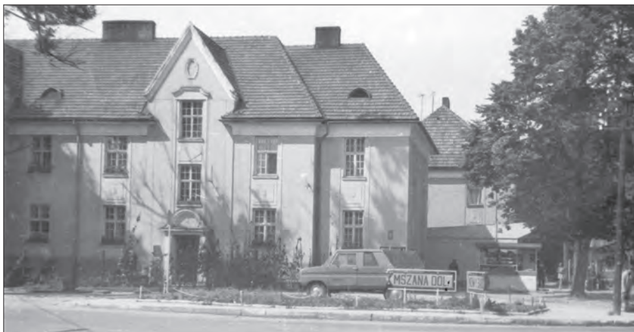
W tym budynku przy ulicy Krakowskiej mieściła się Komisja Likwidacyjna AK i BCh.
