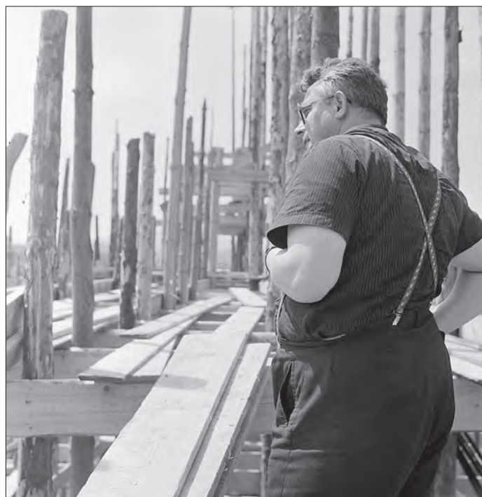
Ks. Jan Bukowiec na rusztowaniach w czasie budowy kościoła.
