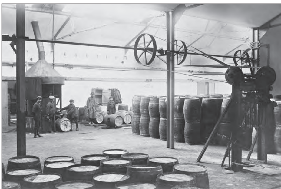
Smarownia w rafinerii nafty w Sowlinach.
