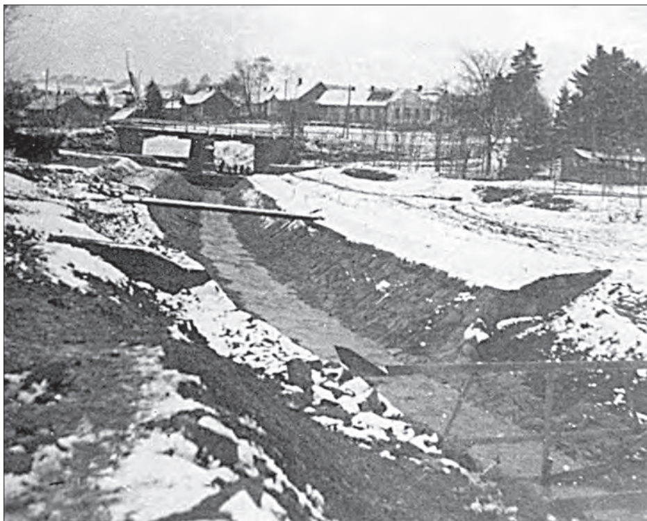
Część uregulowanego potoku Mordarka na wysokości (placu „Dołka”) Sokoła z widoczną kręgielnią po prawej stronie. Pracę przy regulacji potoku wykonywali Polacy - kamieniarka i Żydzi - prace ziemne, 1941 r.
