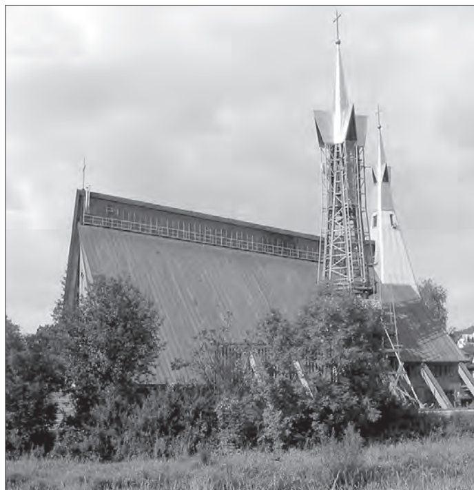
Budowa wieży w kościele w Sowlinach - lipiec 2003 r. [Fot. Franciszek Nataneł]
