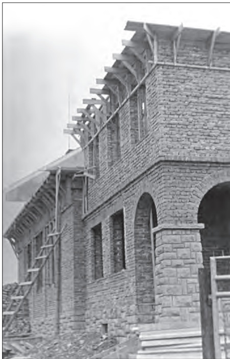
Budynek Domu Nauczyciela - stan surowy. Oddany do użytku 30 kwietnia 1961 roku.
