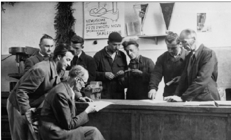
W roku 1950/51 szkoła uzyskała jeden z budynków byłego browaru, w którym uruchomiono warsztat
