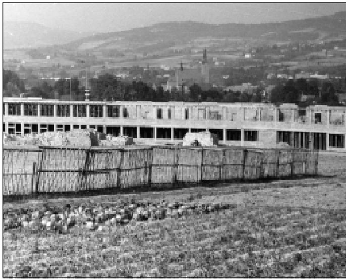
Fragment nowego obiektu szkolnego, którego budowę rozpoczęto w 1964r.
