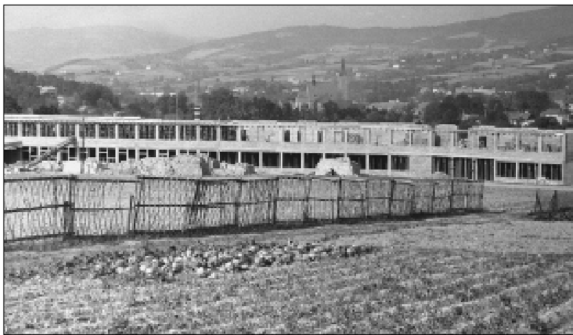
Budowa Technikum Mechanicznego.
