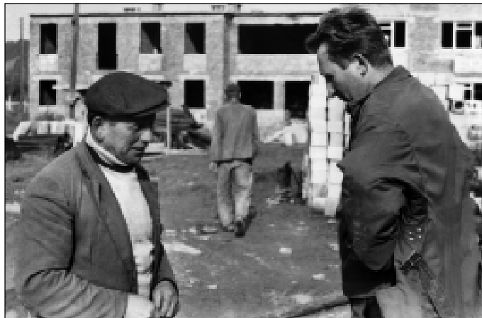
Przed budynkiem administracyjno-mieszaniowym kierownik Dudczyk (z prawej) w rozmowie z pracownikiem technicznym.
