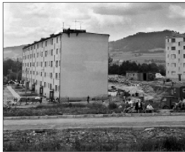
Budowa bloków przy ul. Zygmunta Augusta.
