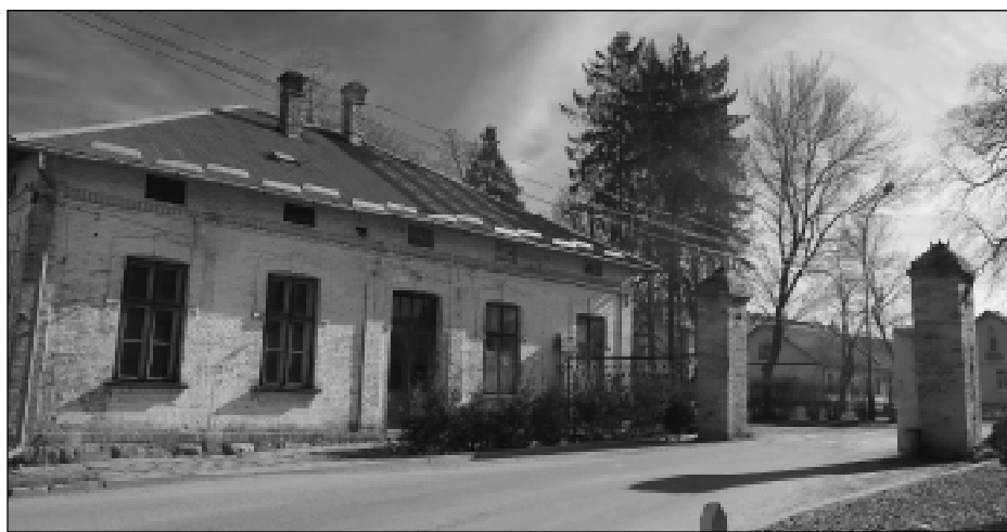
Tu rozpoczynała się przygoda z Rafinerią, kiedy autor wspomnień przychodził do ojca, Franciszka Pankiewicza, urzędującego w tym budynku. Po prawej widoczne ceglane kolumny głównej bramy wjazdowej, w głębi fragment Kolonii Rafinerii.
