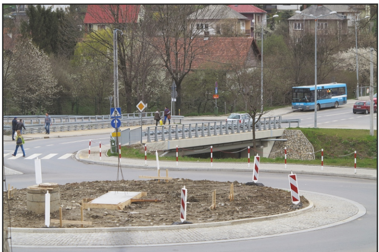
Fundament pod cokół pomnika.
