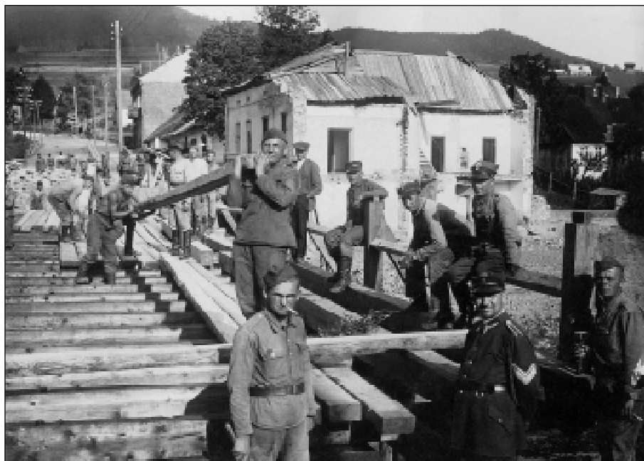
Końcowe prace przy budowie mostu.
