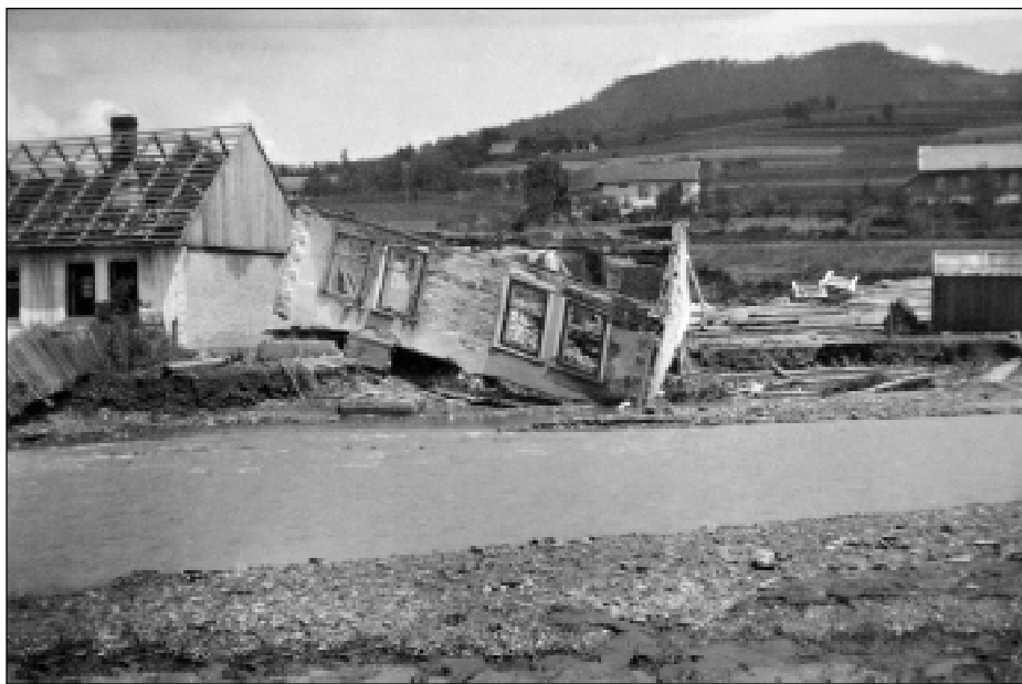
Nurt potoku Mordarka unosił całe budynki.
