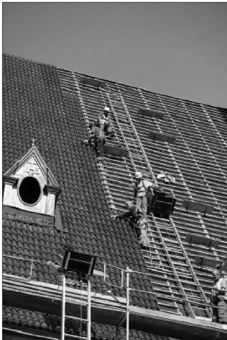
Układanie dachówki „Mnich-Mniszka” od strony południowej bazyliki, widoczne oblachowanie na lukarnie.
