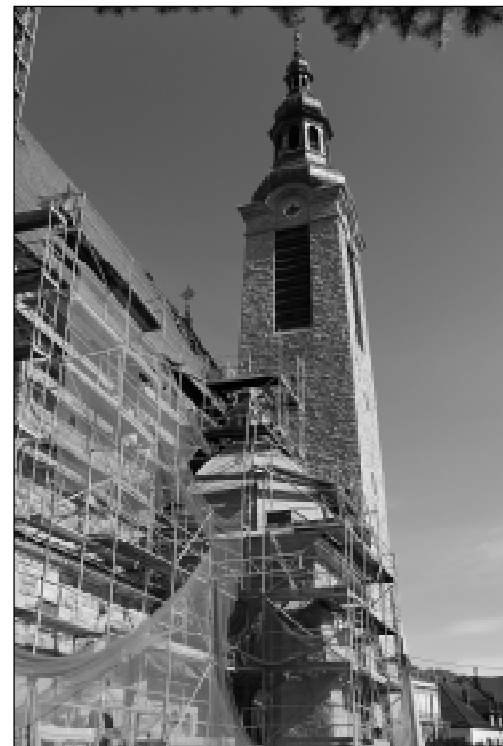
Widok na bazylikę od strony południowej - przedstawia zakres prac II etapu odnowienia świątyni.
