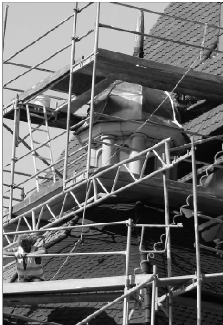
Pokryta farbą dachówka „Karpia łuska” na kaplicy „Serca Jezusowego”, widoczna latarnia kaplicy pokryta blachą miedzianą. Fot. Stanisław Ociepka
