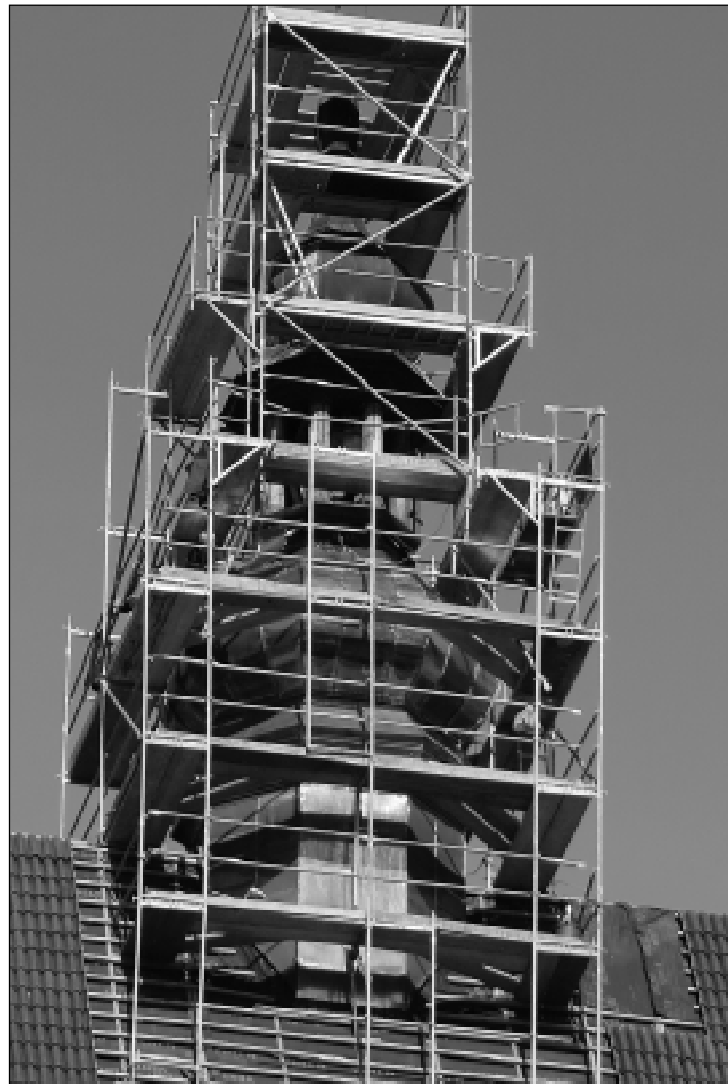
Wymiana blachy miedzianej na wieży - sygnaturki.
