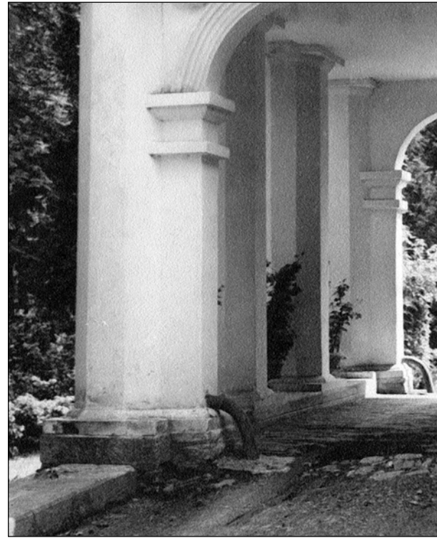
Otwarty ganek na podjeździe przed wejściem do dworu.
