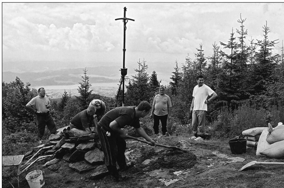
Prace przy Krzyżu papieskim na Lubaniu.
