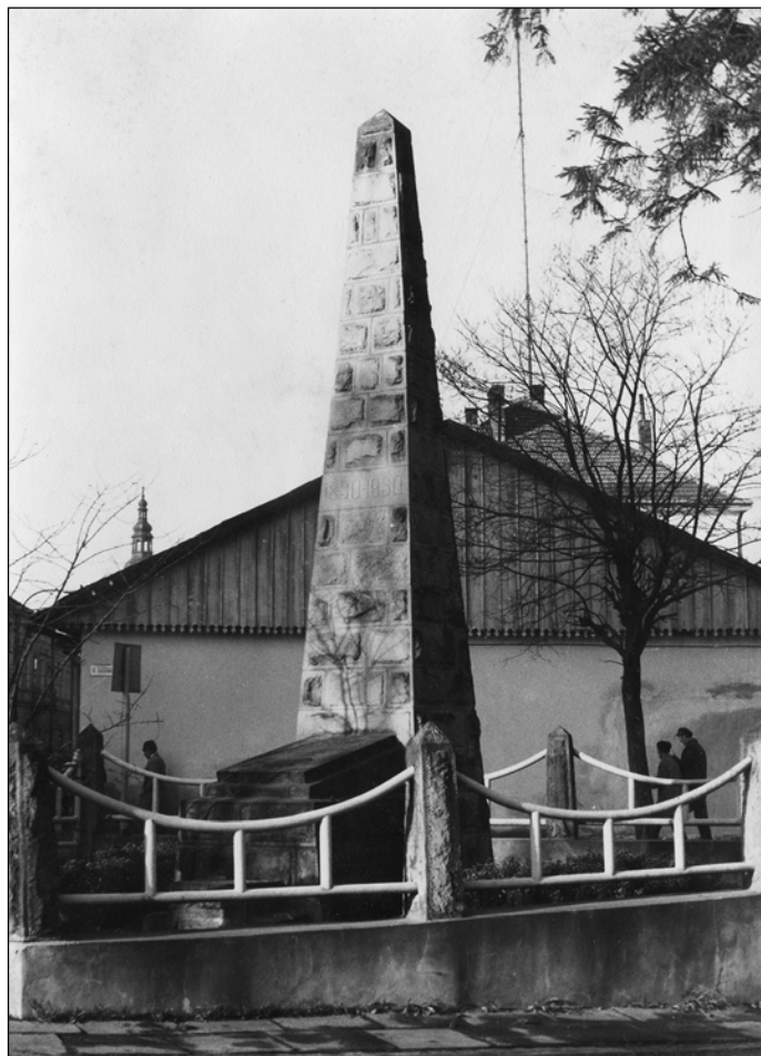
Pomnik Nieznanego Żołnierza na jego pierwotnym miejscu, w tle budynek limanowskiego gniazda „Sokoła”.
