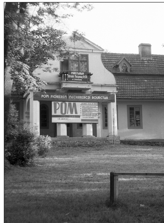
Budynek dworu Marsów w roli siedziby biur Państwowego Ośrodka Maszynowego - widok od strony północnej na interesującą architekturę ganku; lata 50.-60. XX wieku. Fot. J. Staniszewski
