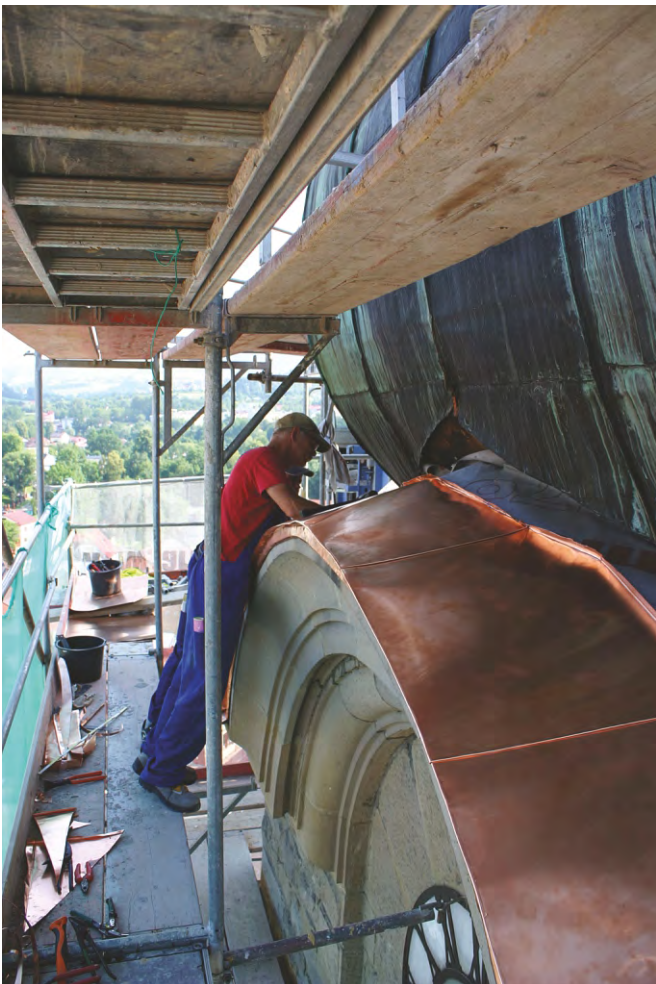
Pracownicy firmy Łaczyńskiego przy konserwacji hełmu wieży.
