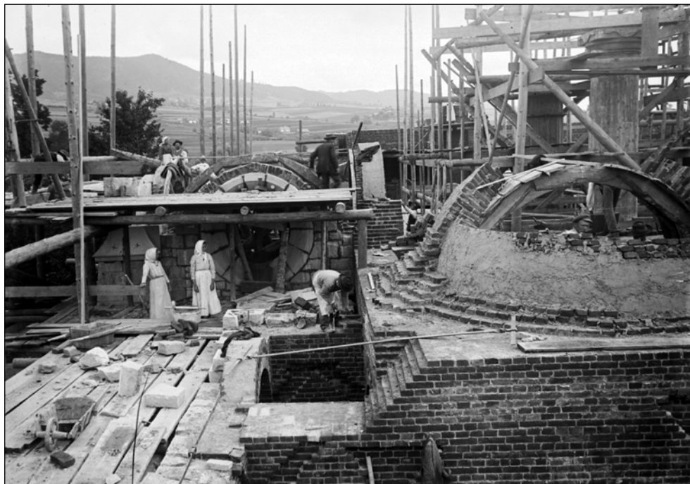
Pośród rusztowań widoczne kolumny z kapitelami, na pierwszym planie murarze przy łuku arkady ołtarza św. Józefa, obok widoczny wylot tunelu klatki schodowej z kręconymi schodami prowadzącymi na ambonę.
