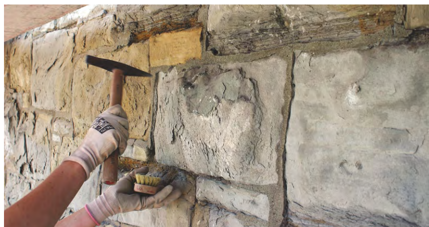
Powyżej: Krzyszyna Menio , kierownik delegatury w Nowym Sączu, Woj. Urzędu Ochrony Zabytków w Krakowie ukazuje skalę zniszczenia drewnianych konstrukcji wieży. Poniżej: Prace konserwatorskie kamiennej okładziny wieży kościoła.
