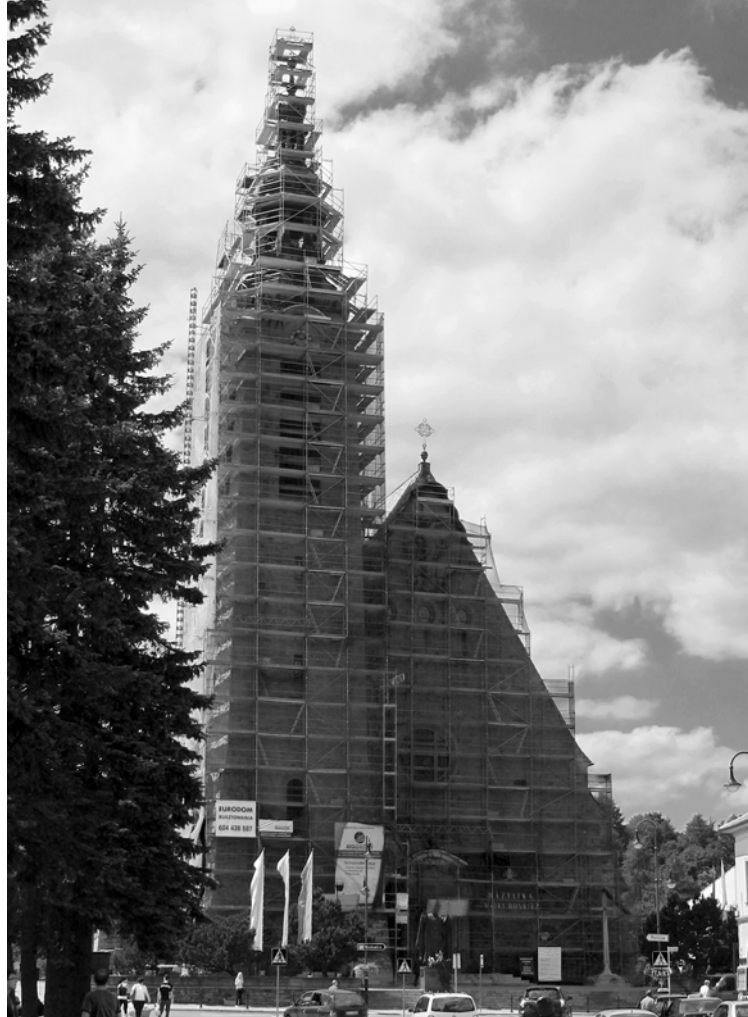
Widok remontowanej bazyliki od północnej strony rynku. Fot. St. Ocieпка
