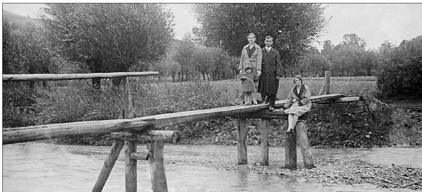
Kładka na Potoku Starowiejskim między dzisiejszymi limanowskimi cmentarzami - lata międzywojenne. Obecnie w tym miejscu znajduje się most.
