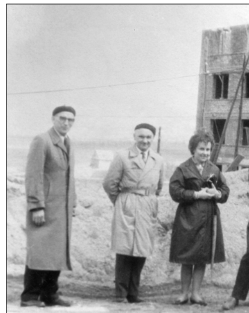
Nauczyciele na placu budowy nowej szkoły. Stoją od dyr. T. Ociepka, H. Bednarczyk, B. Tyrkiel - 1965 r.
