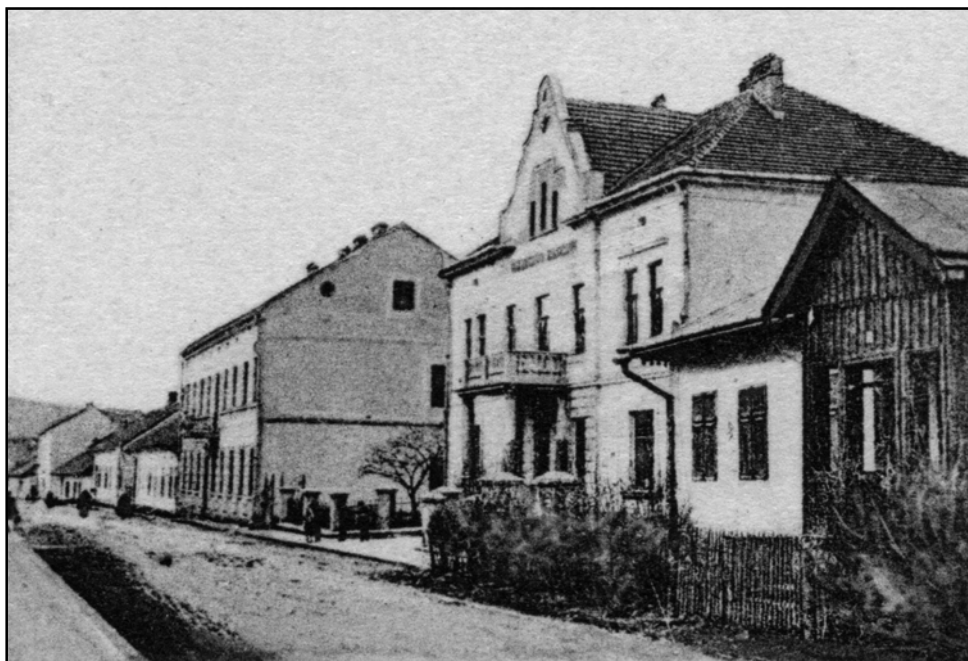
Pałacyk pod „Pszczołką”, przy ul. W. Zubrzyckiego, w którym mieściła się Kasa Zaliczkowa - początek XX w.
