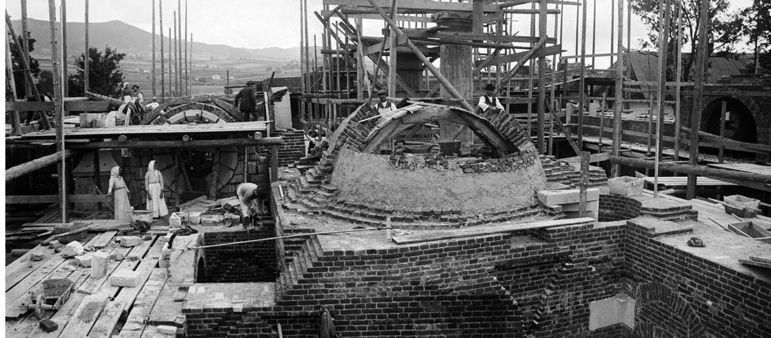
Budowa limanowskiego kościoła - 1912 rok. W tle panorama Lysej Góry.
