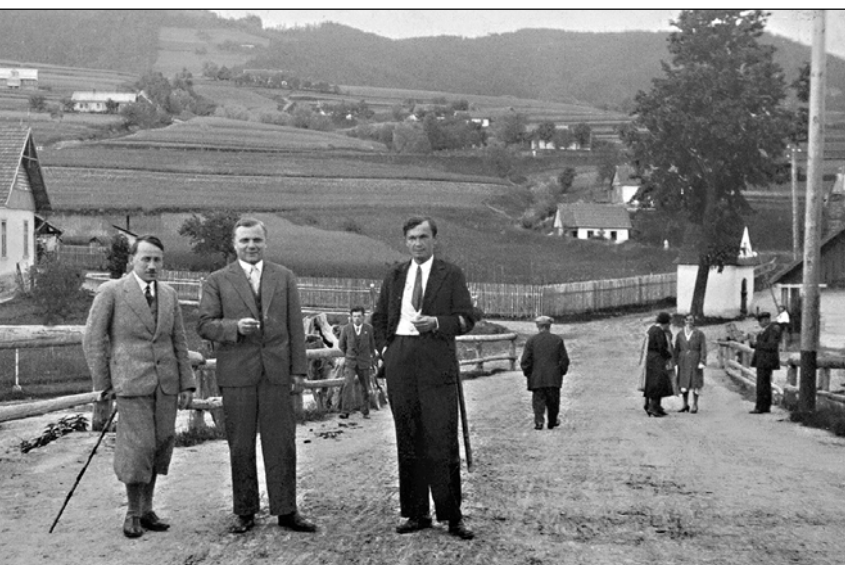
Przy „Targowicy”. Po lewej dom Stanisława Zielińskiego, później adwokata Jerzego Kwiecińskiego, na końcu drogi kapliczka.
