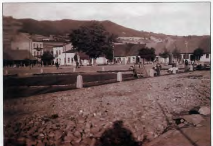
Prace remontowe na rynku w czasie okupacji.
