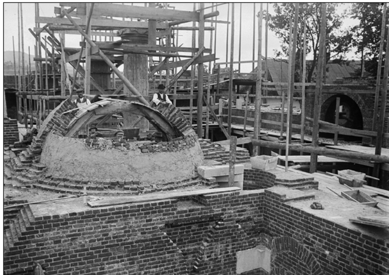
Fotografia Klementyny Zubrzyckiej-Bączkowskiej z budowy limanowskiego kościoła - 1912 rok.
