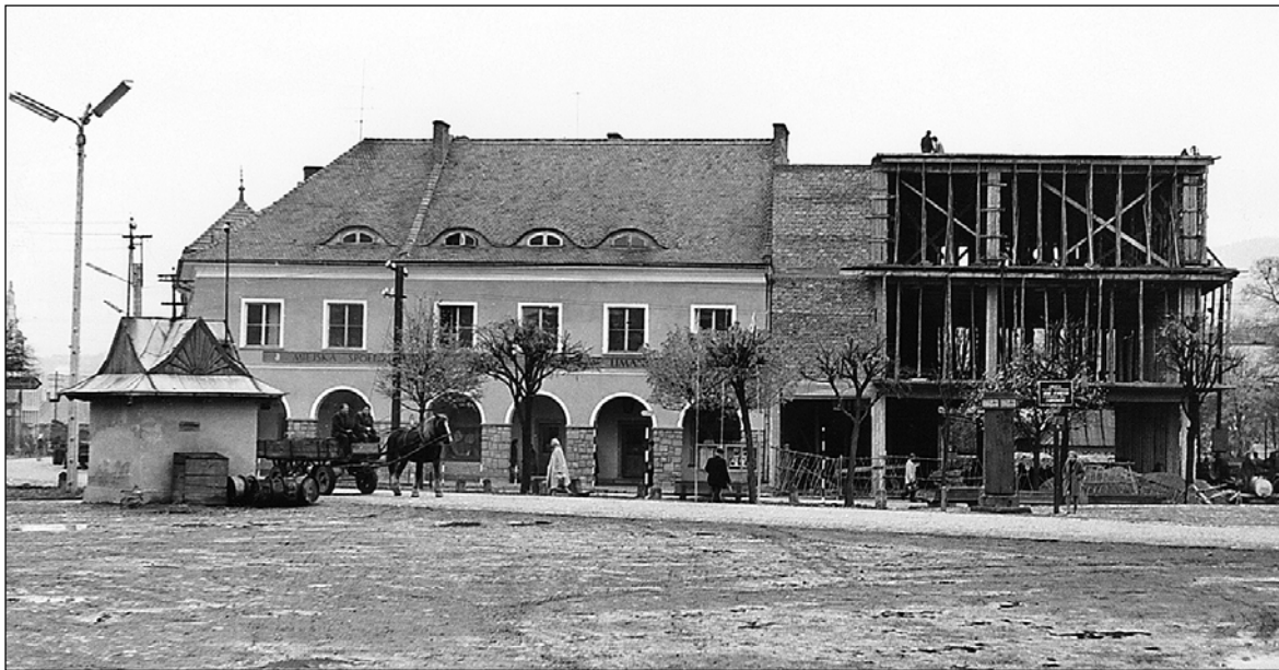
Budowa domu towarowego „Orion” została rozpoczęta w 1962 roku, a oddano go do użytku 1 maja 1965 roku.
